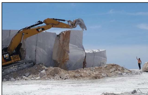
Figura 2: ribaltamento bancata con escavatore
