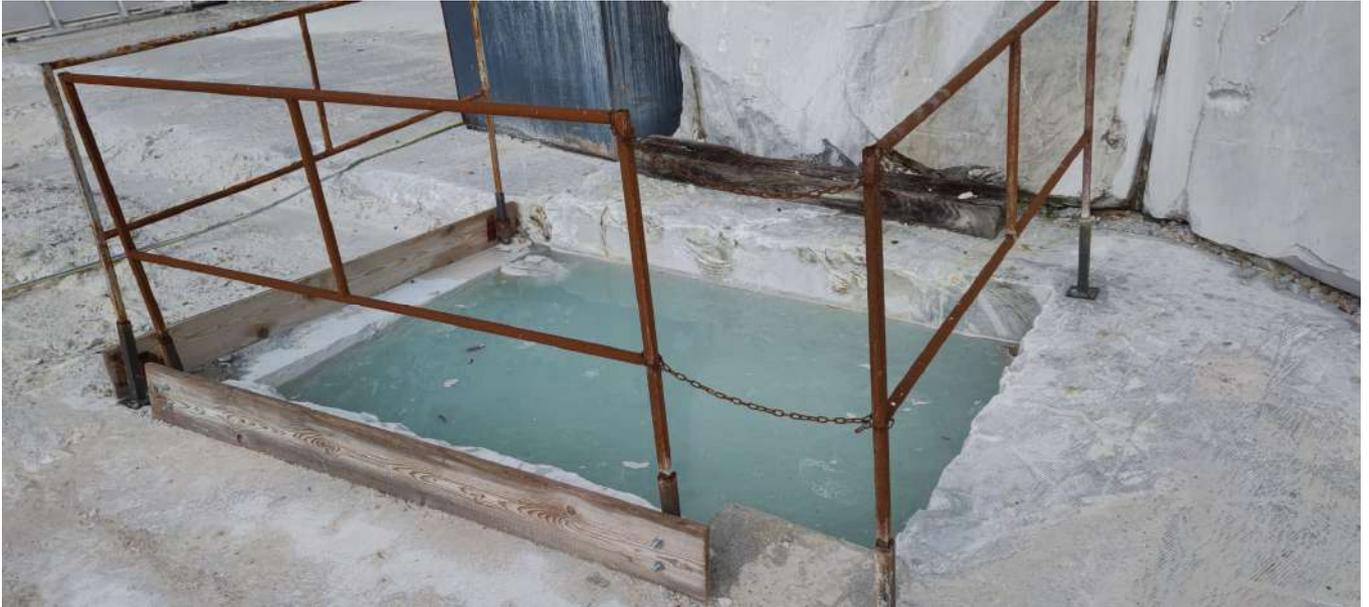
**Figura 19:** Vasca di raccolta delle acque sotterranee localizzata presso il portale della galleria Nord.
