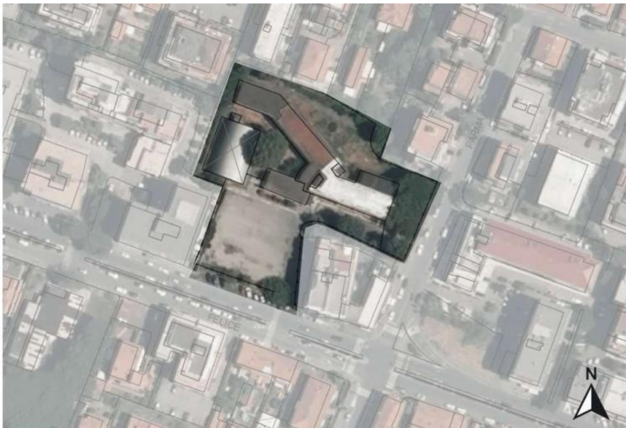
Figura 1 - Stato attuale dell'area di intervento e l'edificio scolastico oggetto di demolizione
