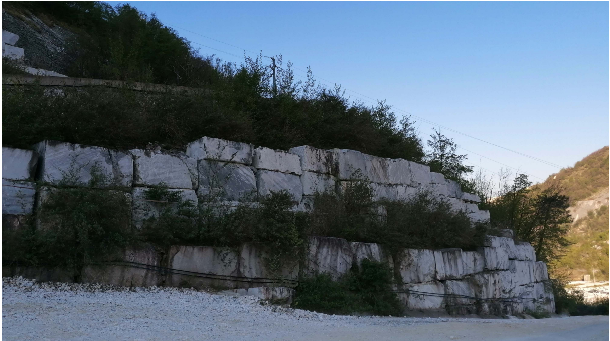
Foto a) Rivegetazione spontanea avvenuta lungo una strada comprensoriale di bacino ove sono stati impilati massi ciclopici
