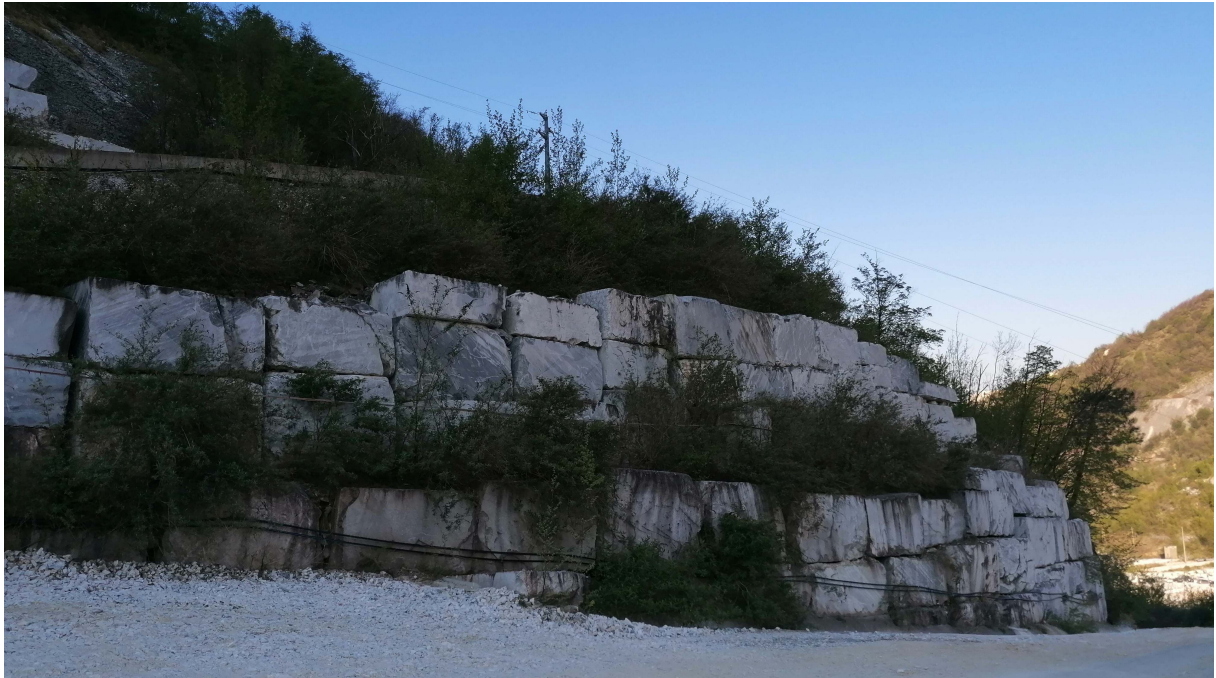
Foto a) Rivegetazione spontanea avvenuta lungo una strada comprensoriale di bacino ove sono stati impilati massi ciclopici
