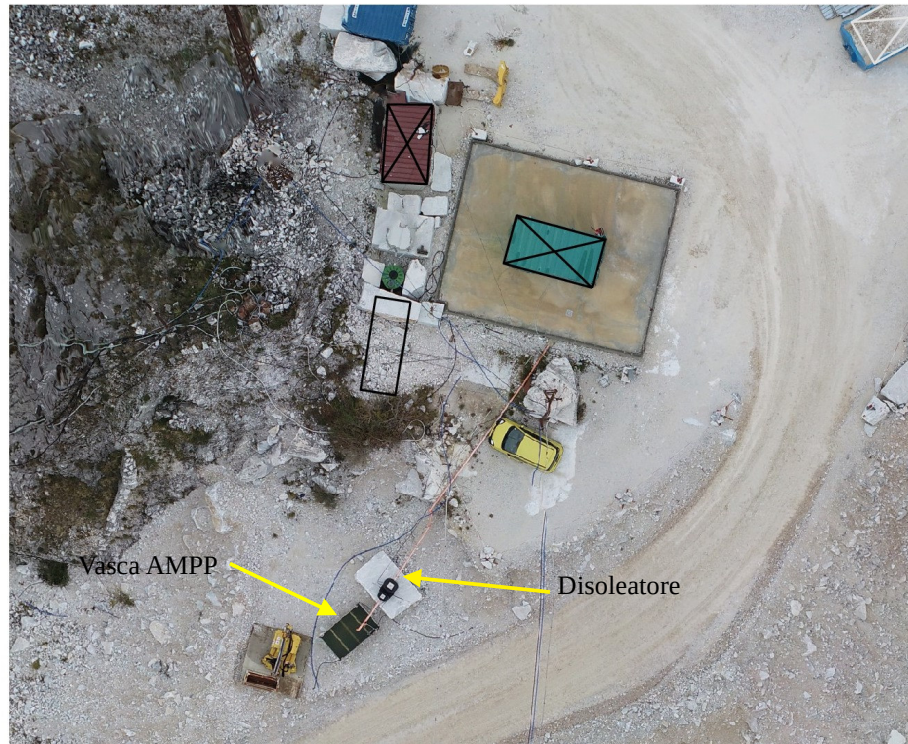
Foto 2 - Orotofoto dell'area gasolio posta nel Cantiere Superiore
