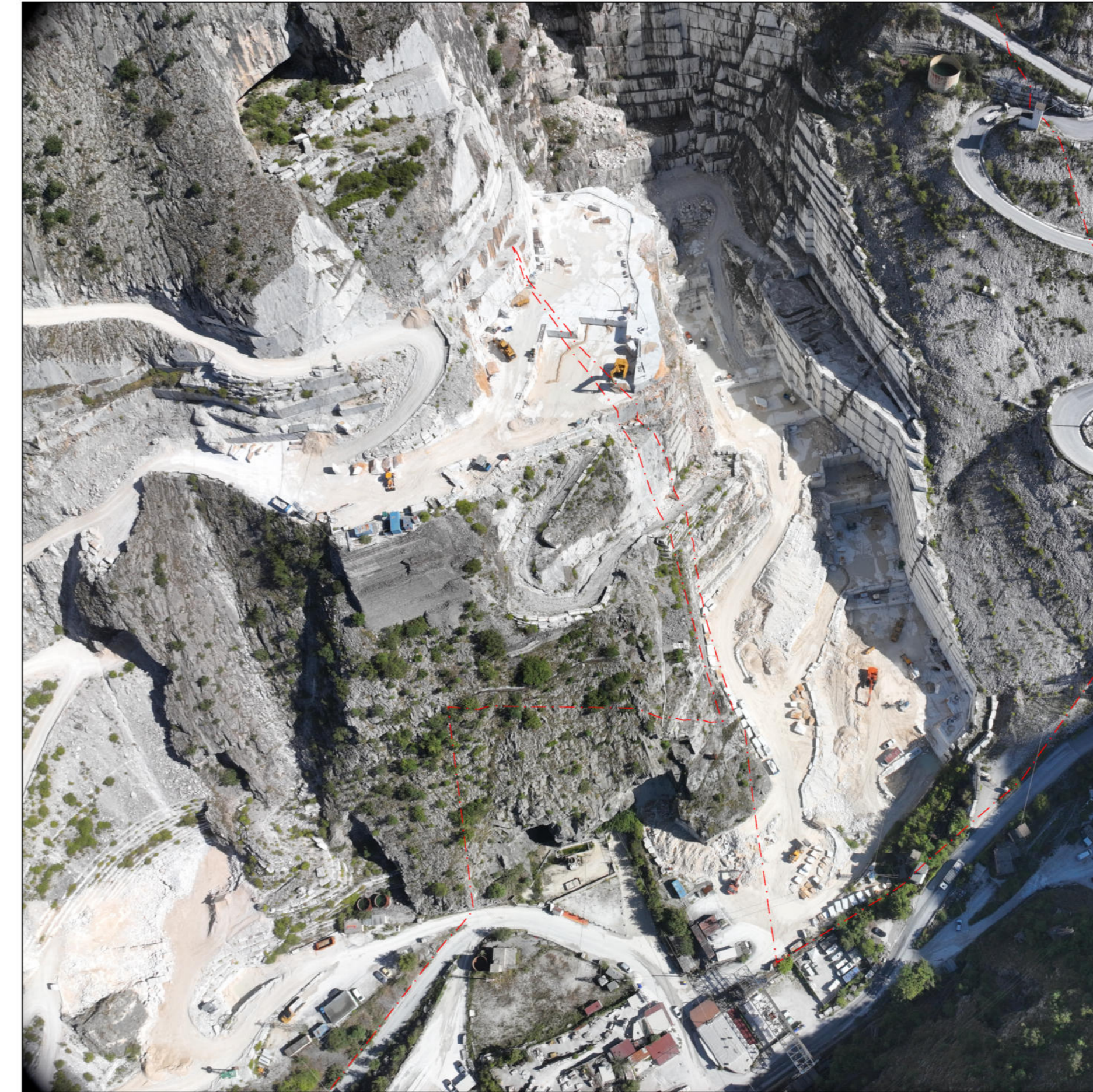
Panoramica stato attuale - Cantiere intermedio e inferiore
