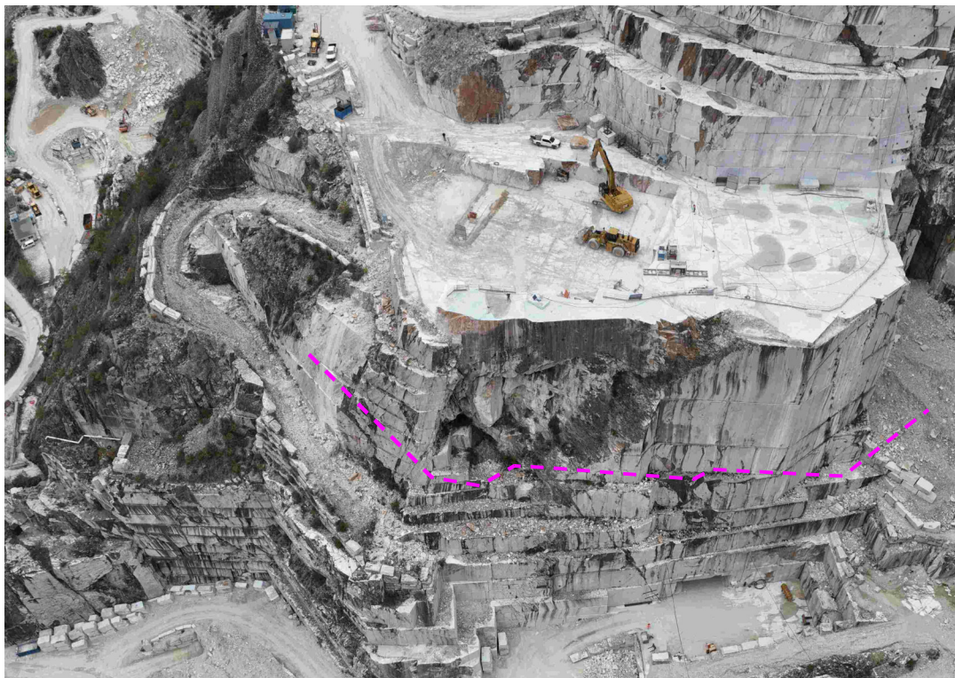
Panoramica del fronte che si sviluppa dal cantiere Scaloni in cui le lavorazioni risultano in parte essere una messa in sicurezza dell'area. In colore la quota approssimata di 490 ca.
