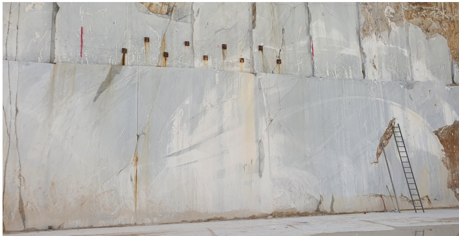
Panoramica del fronte al momento dell'apertura del sotterraneo W con visibile l'intervento di consolidamento del portale.
