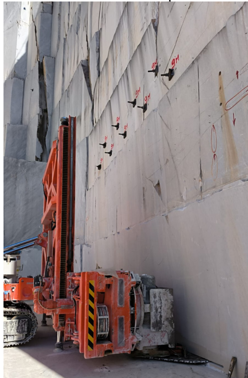
Panoramica del fronte al momento dell'apertura del sotterraneo E con visibile l'intervento di consolidamento del portale.
