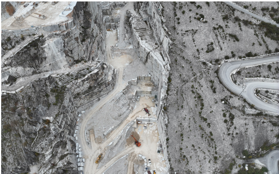
Panoramica dei fronti di cava del cantiere Inferiore
