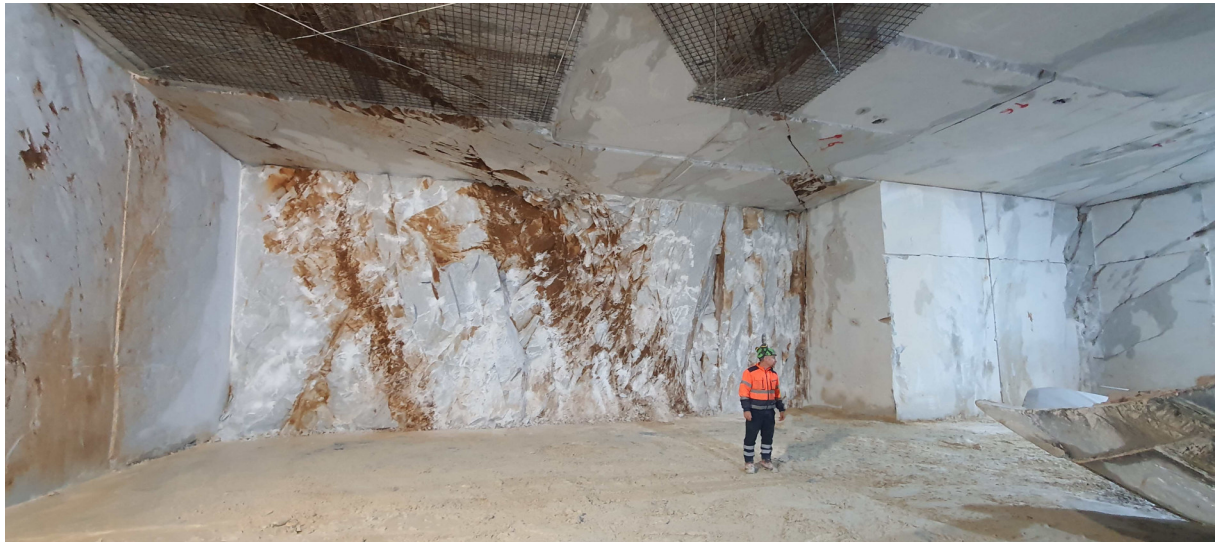
Particolare della struttura intercettata.
