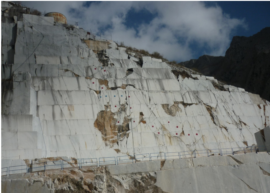
Panoramica del fronte sovrastante il cantiere Zucchetto, con visibili gli interventi eseguiti.
