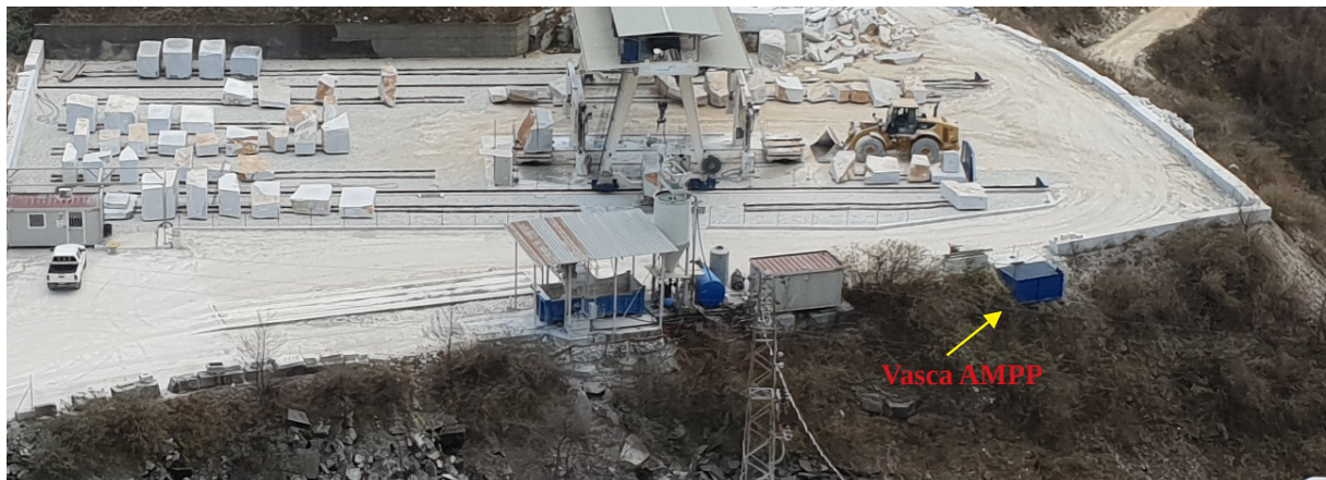
Panoramica area impianti deposito con indicata la posizione della vasca
