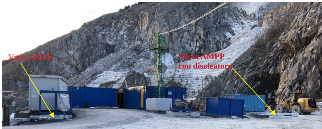
Panoramica dell'area impianti 1.
