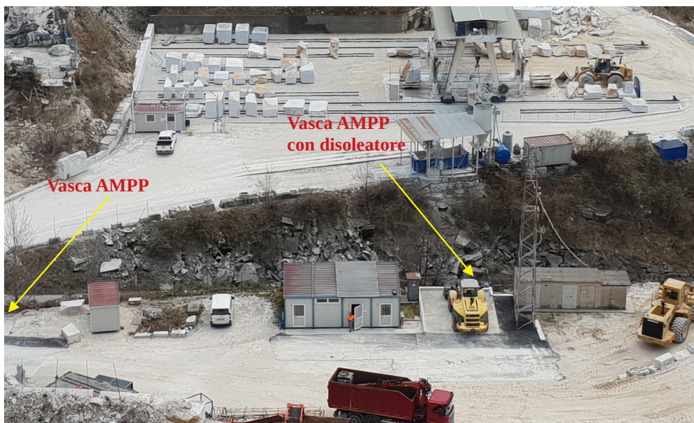
Panoramica dell'area impianti 2.
