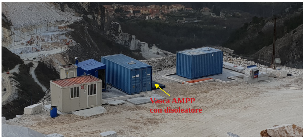
Panoramica dell'area impianti 3.
