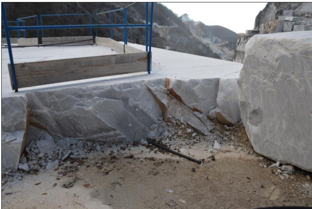
Immagine fotografica della qualità di marmo più chiara affiorante lungo la porzione meridionale del cantiere zucchetto.
