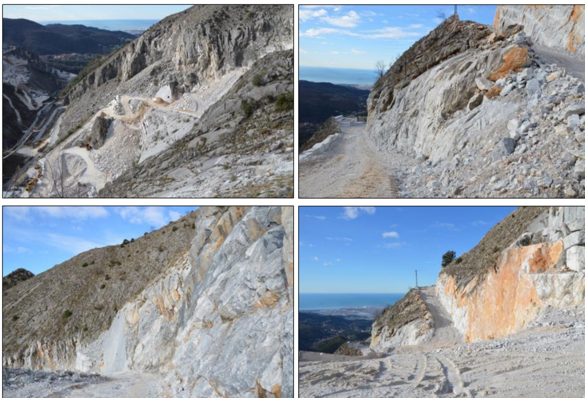
Immagini fotografiche dei fronti lungo la viabilità di arroccamento ai cantieri superiori.
