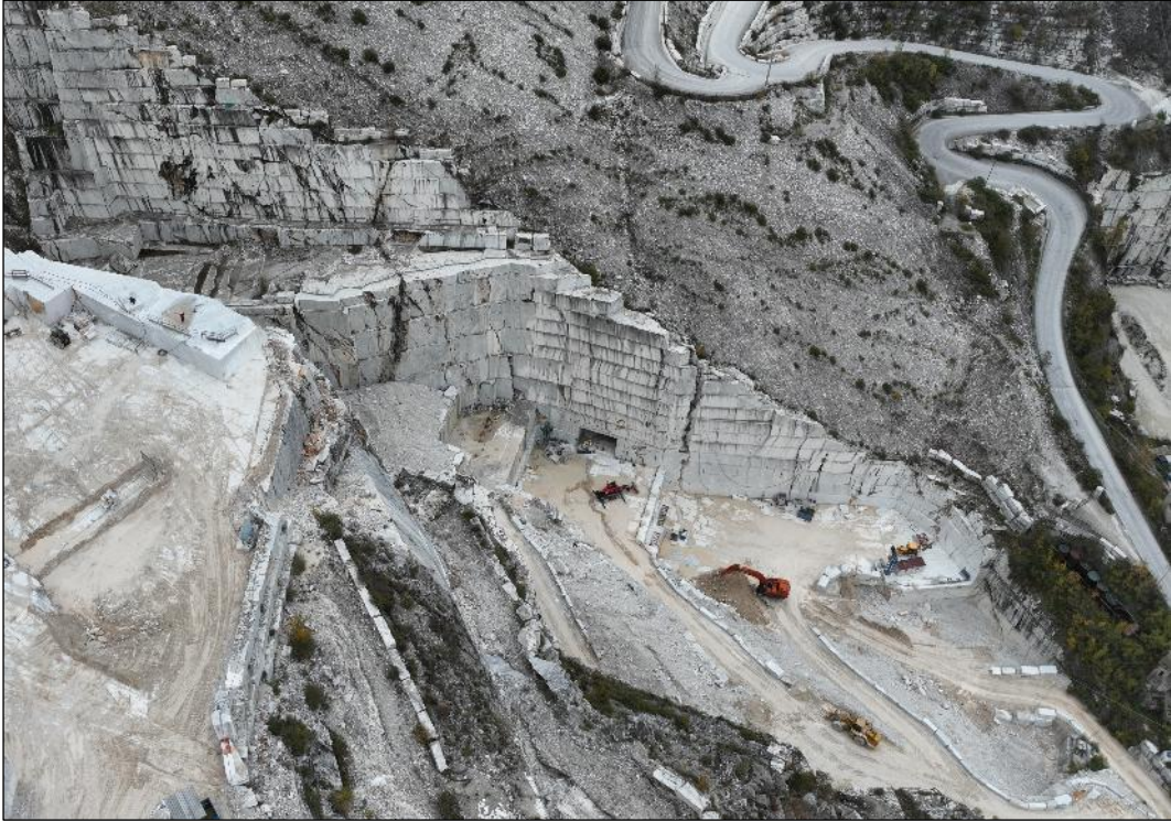
Immagine fotografica ripresa da drone dell'ingresso della galleria orientale della cava "Fantiscritti B n.92"
