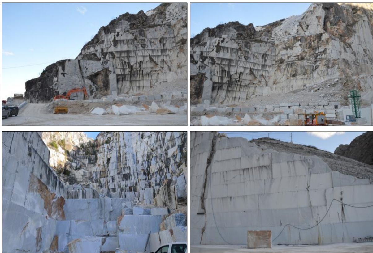
Immagini fotografiche del cantiere inferiore della cava "Fantiscritti B n.92".
