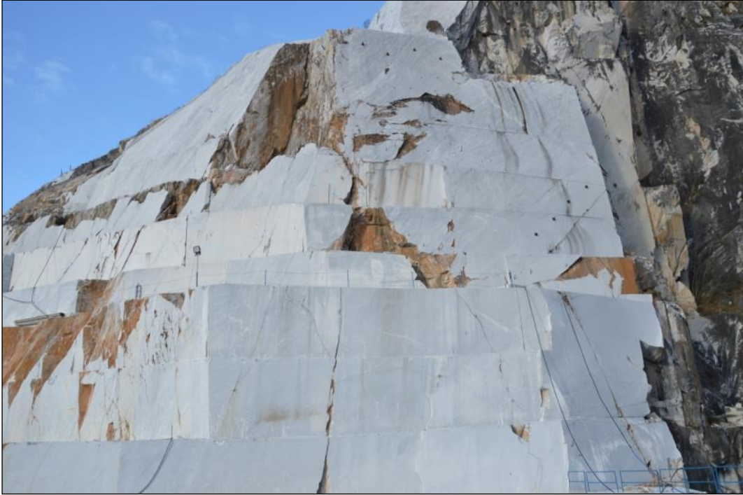
Immagine fotografica della porzione apicale del fronte che contorna il cantiere inferiore della cava "Fantiscritti B n.92" verso ovest. È possibile notare lungo le superfici di taglio il passaggio tra le qualità più scure sopra (nivolato e grigio) e le qualità più chiare sotto (bianco ordinario C e C/D).
