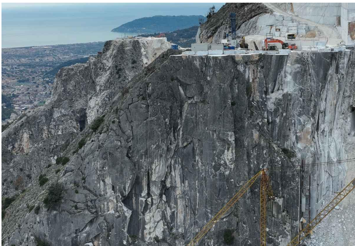
Panoramica della porzione superiore del fronte principale da asportare per garantire sicurezza delle aree sottostanti
