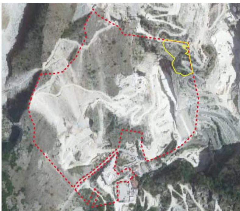
Ortofoto con il ravaneto R1 in giallo e in rosso il perimetro del cantiere "Fantiscritti B" n.92.
