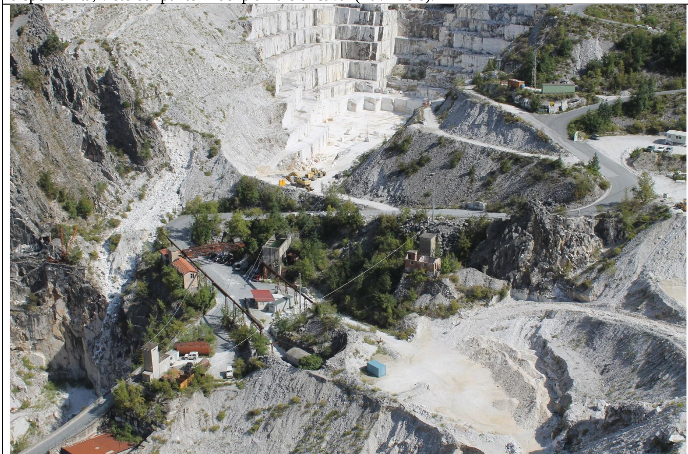
Foto 2: Punto A – Panoramica del Ravaneto R1 collocato nel settore nord-orientale dell'area in disponibilità, visto dal punto A del piazzale di cava (Tav22bis.).
