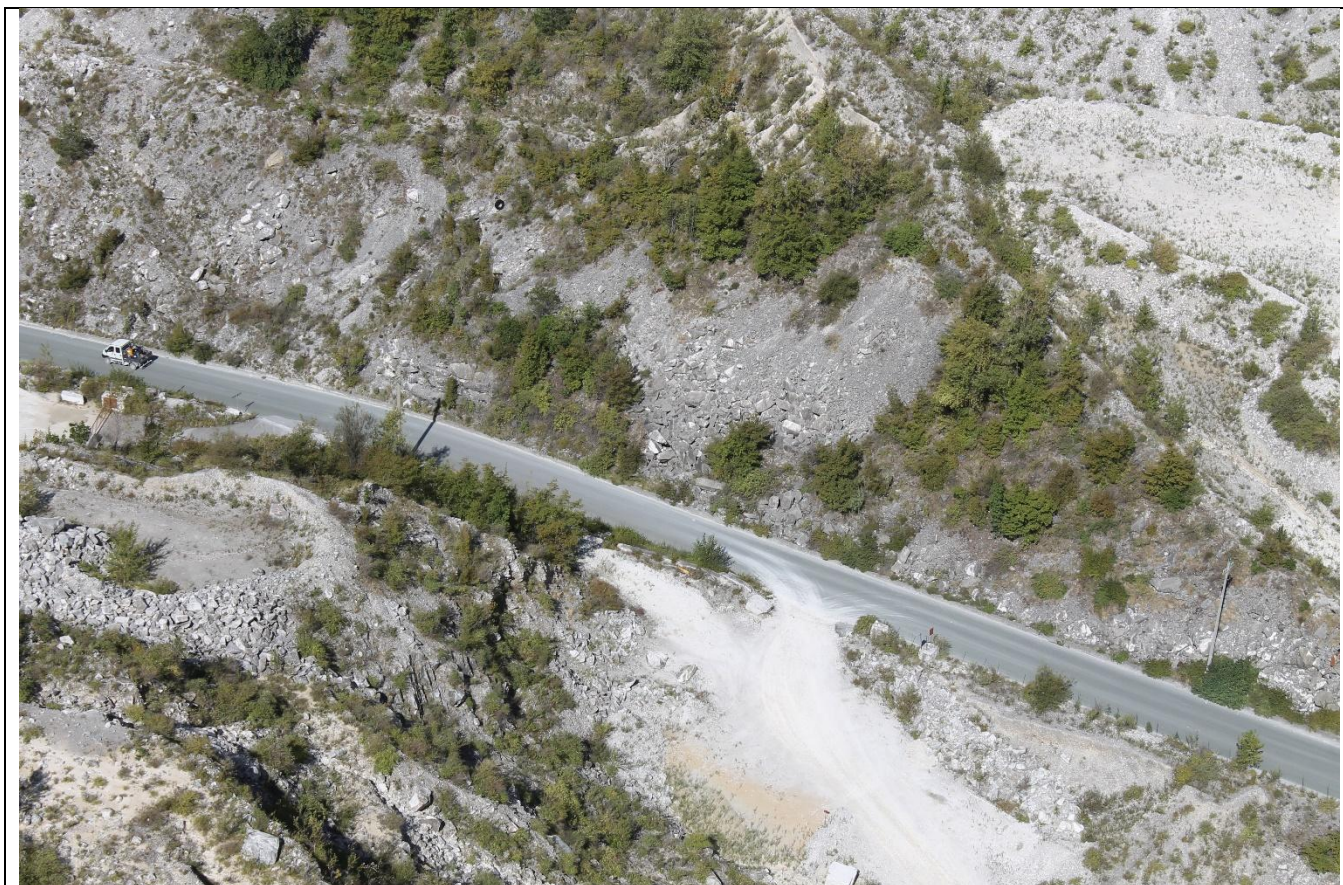
Foto 1: Punto A – Panoramica del Ravaneto R1 collocato nel settore nord-occidentale dell'area in disponibilità, visto dal punto A del piazzale di cava (Tav 22bis).
