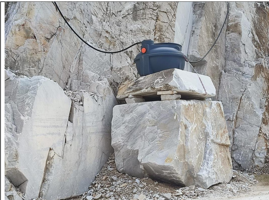
Foto 3: il disoleatore con la gomma di afflusso dell'area impianti (a destra) e quella d'uscita al serbatoio D1 (a sinistra).
