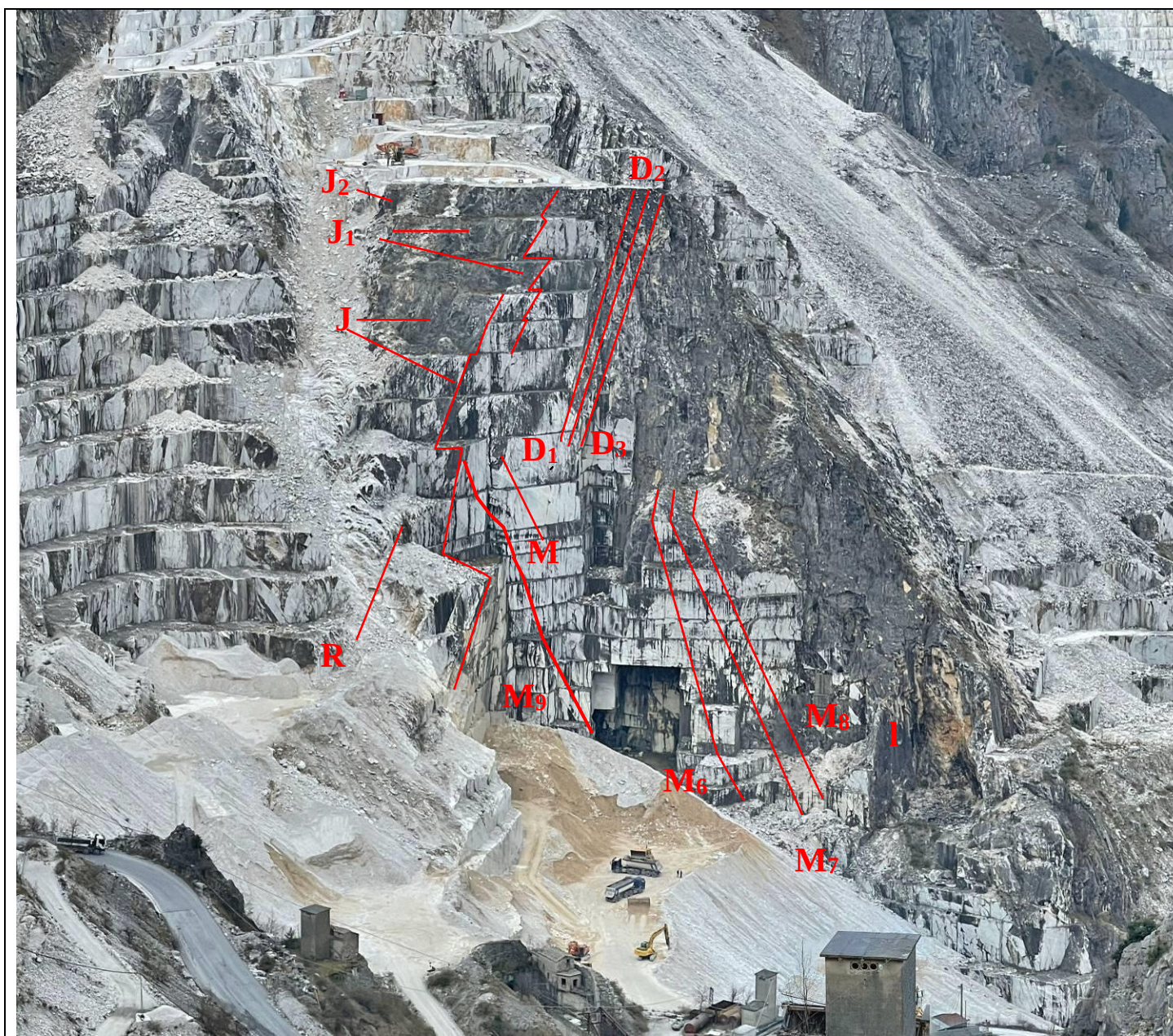
Foto 7: Stato attuale variante. Immagine scattata dalla strada asfaltata di comparto, rettilo sopra cava Amministrazione. In evidenza le fratture principali e più significative del settore meridionale.
