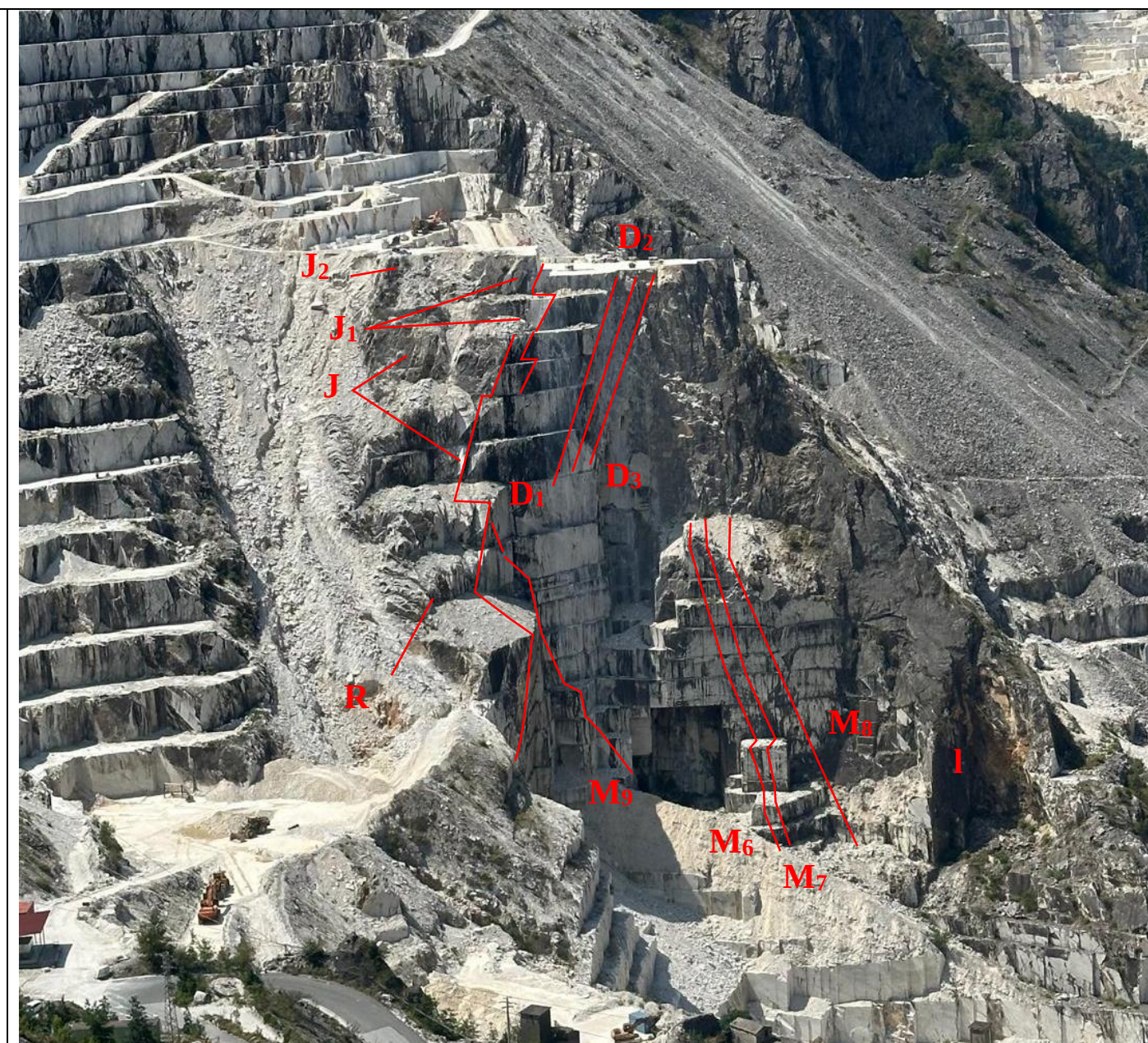
Foto 8: Stato attuale progetto. Immagine scattata dalla strada asfaltata di comparto, rettilo sopra cava Amministrazione, con posizione all'incirca uguale alla Foto 5. In evidenza le fratture principali e più significative del settore meridionale.
