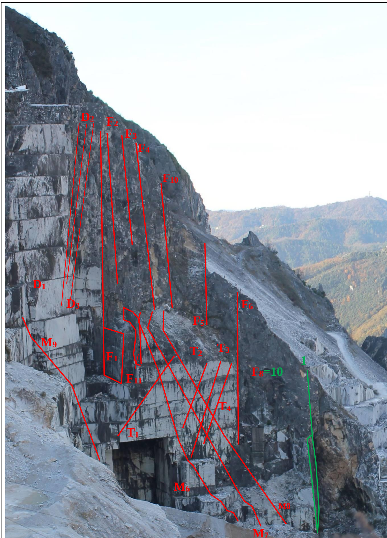
Foto 17: Variante: Stato attuale definizione delle discontinuità principali rilevate e all'interno del settore centrale viste dalla strada asfaltata di comparto.
