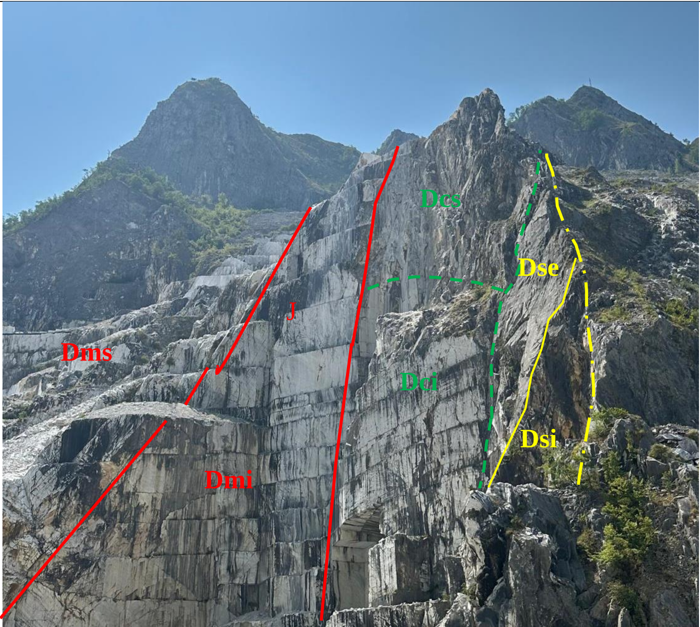
Foto 6: Stato Attuale progetto. Immagine scattata dalla strada comunale nei pressi dell'entrata superiore del Cantiere Vecchia Cava, con posizione all'incirca uguale alla foto 5. La Frattura J= 045/64° suddivide il settore nei due domini: Dominio Meridionale superiore (Dms); Dominio centrale superiore (Dcs) Dominio settentrionale esterno (Dss); Dominio Meridionale inferiore (Dmi); Dominio centrale inferiore (Dci) Dominio settentrionale interno (Dsi)
