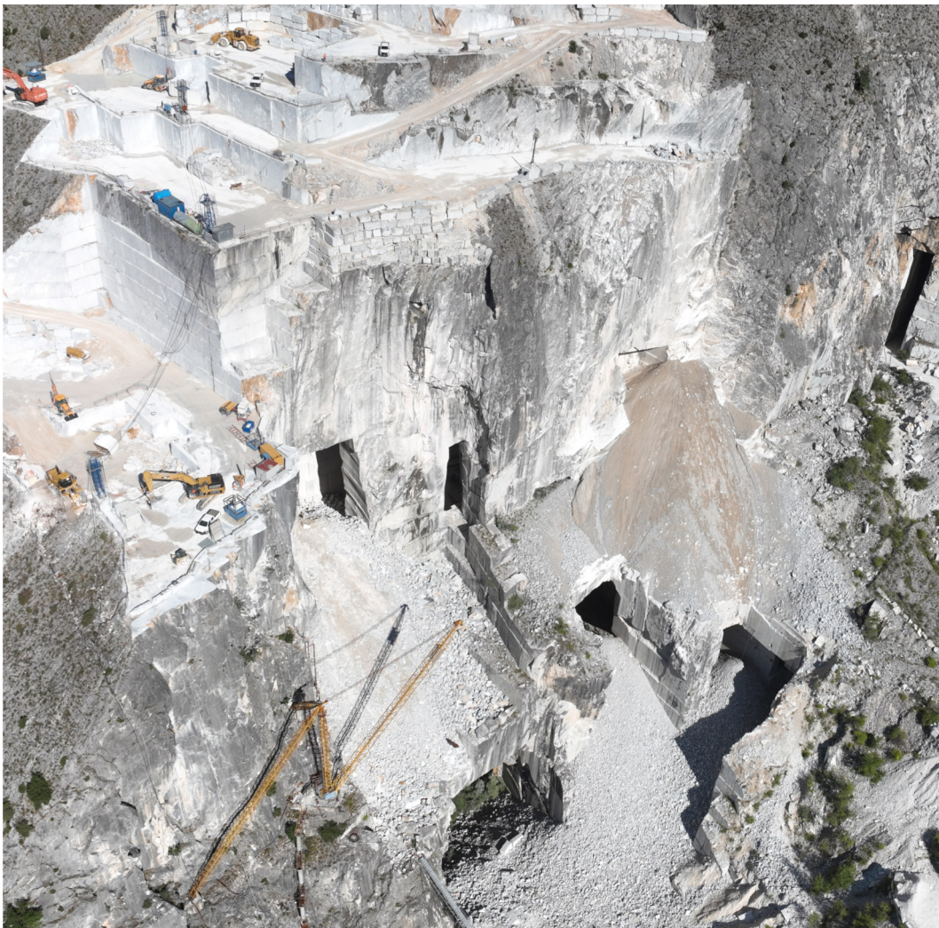
Panoramica della porzione del fronte principale da asportare per garantire sicurezza delle aree sottostanti
