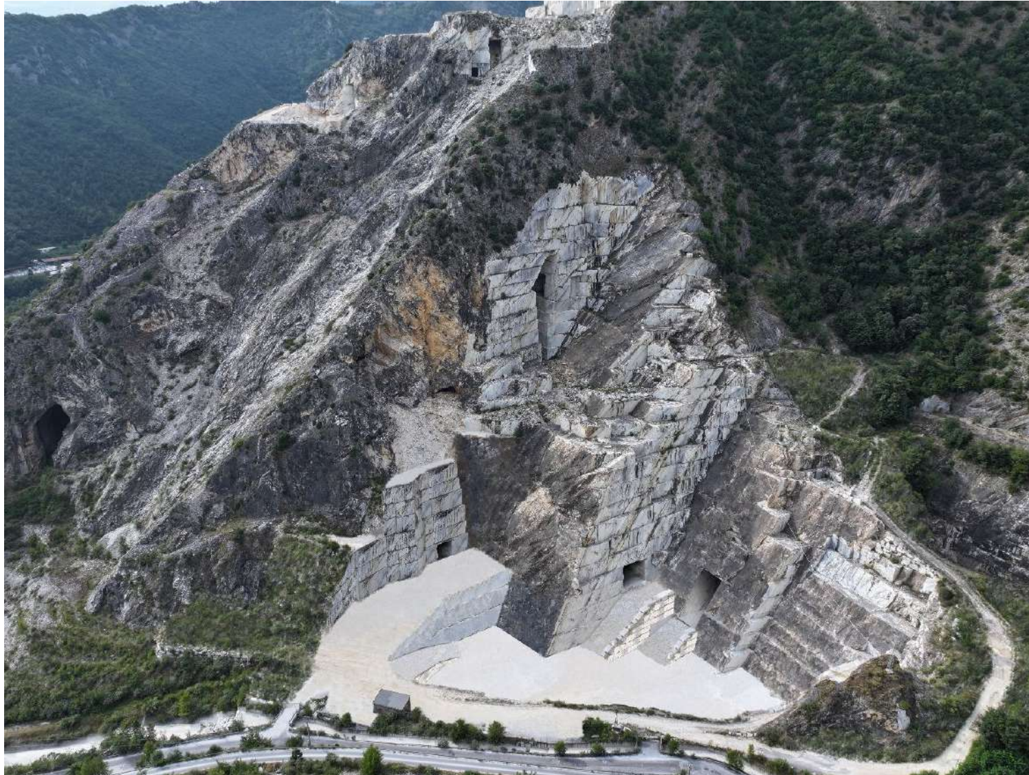
Figura 3: Panoramica da drone: fotosimulazione dello stato ripristinato.
