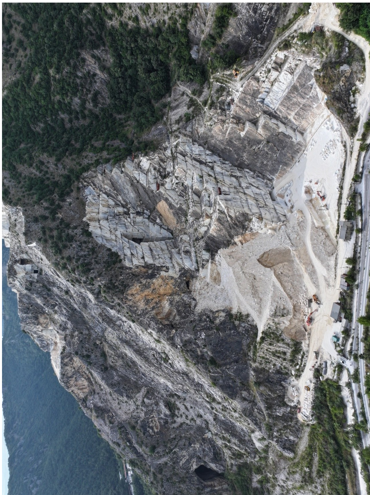
Foto stato attuale
