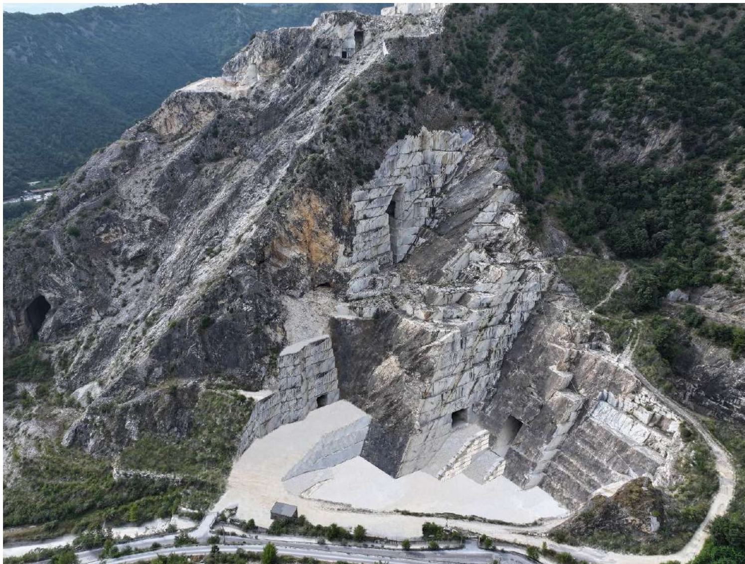
Figura 3: Panoramica da drone: fotosimulazione dello stato ripristinato.
