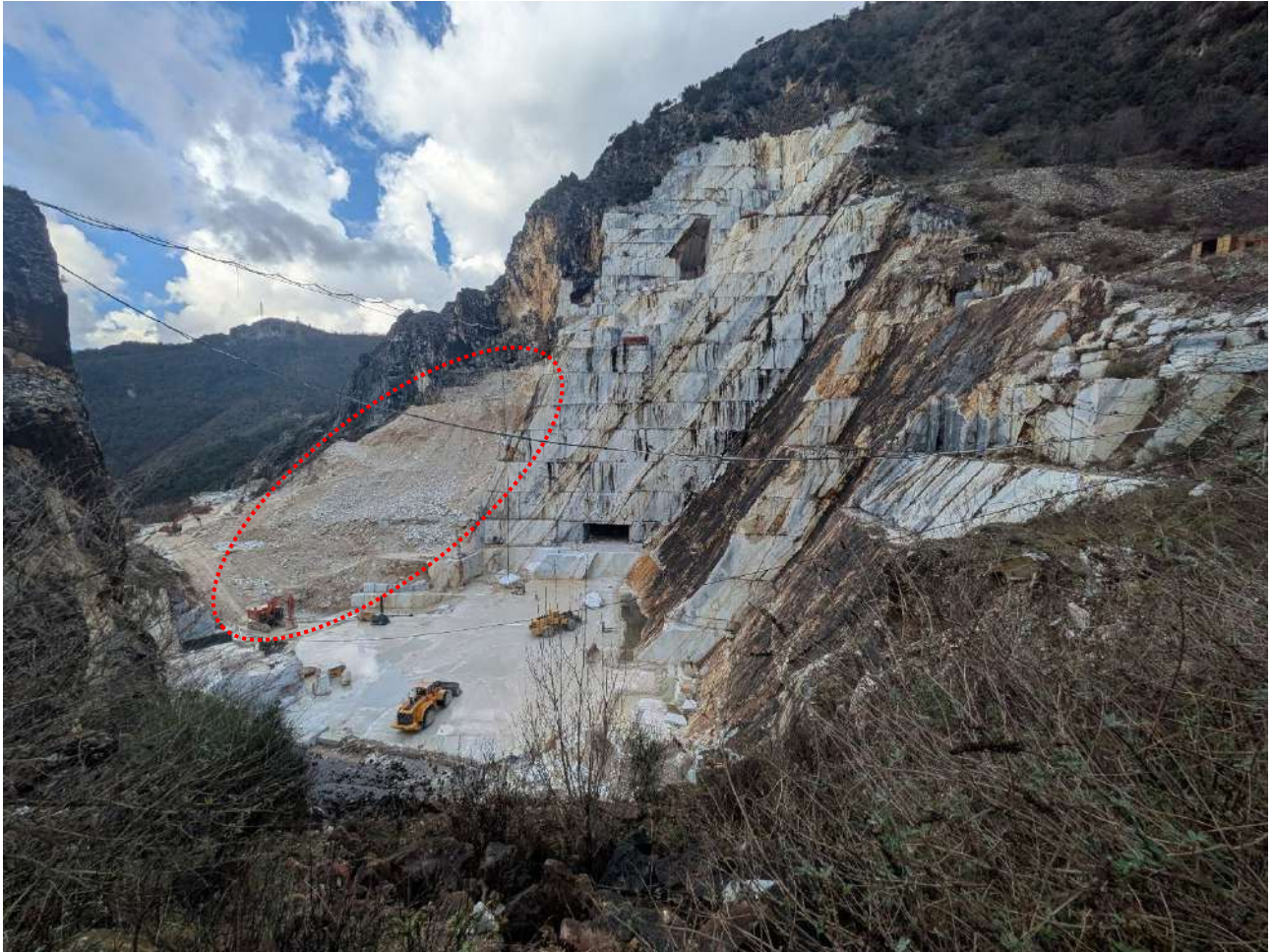
Figura 14: Vista del cumulo detritico risultante dalle attività di bonifica del cantiere “superiore”, da rimuovere per motivi di sicurezza che del buon governo del giacimento.
