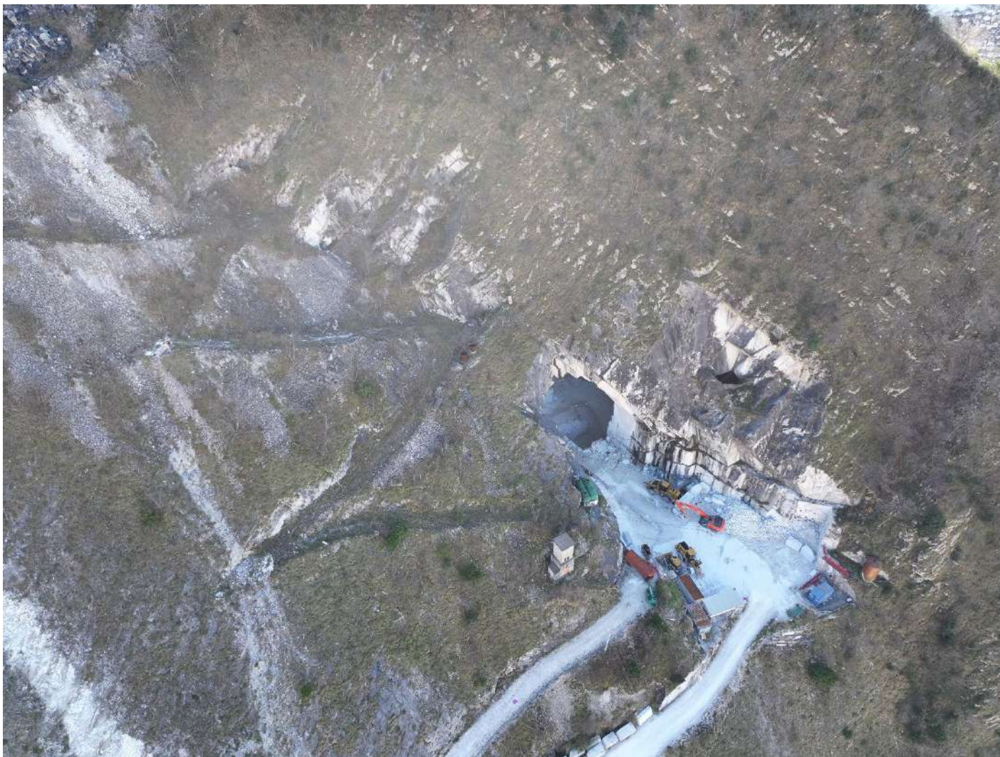
Figura 14: Il tracciato stradale esistente su cui devono essere eseguiti lavori di ripulitura che interessano, in alcuni tratti, aree boscate ( punti 2-3 Figura 5). Il ravaneto R1 risulta rinaturalizzato con un buon contingente specie autoctone ma anche specie invasive, sulle quali intervenire per garantire l'espansione delle essenze autoctone stesse.
