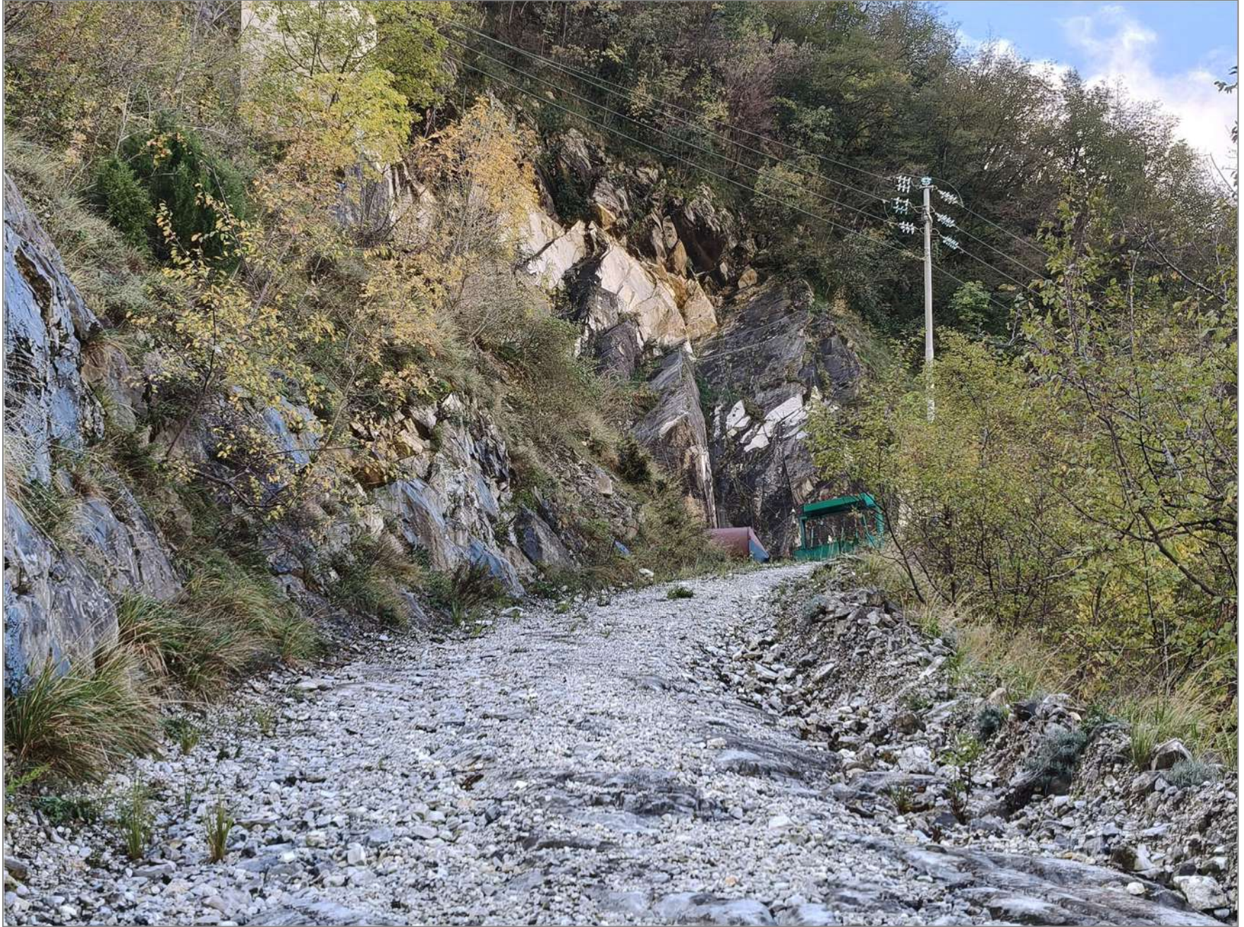
Figura 15: Il primo tratto del tracciato stradale esistente.
