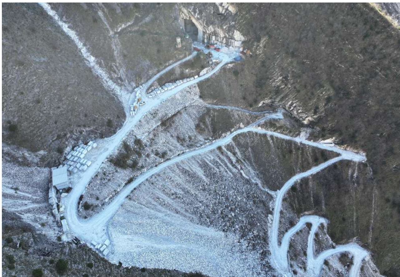
Figura 3: Veduta della via di arroccamento comprensoriale situata lungo il ravaneto e l’impluvio del Fosso Val Pulita.
