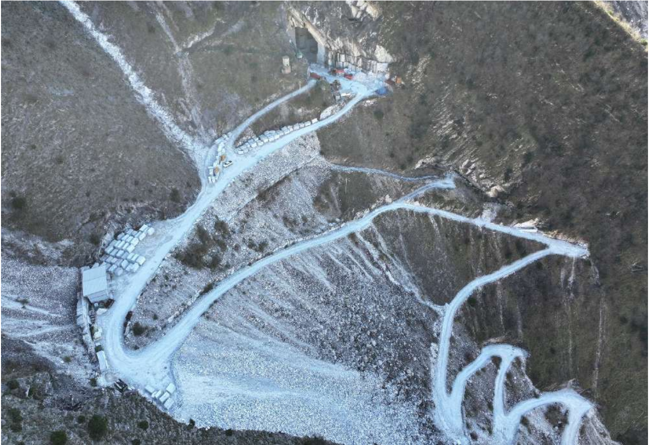
Figura 3: Veduta della via di arroccamento comprensoriale situata lungo il ravaneto e l'impluvio del Fosso Val Pulita.
