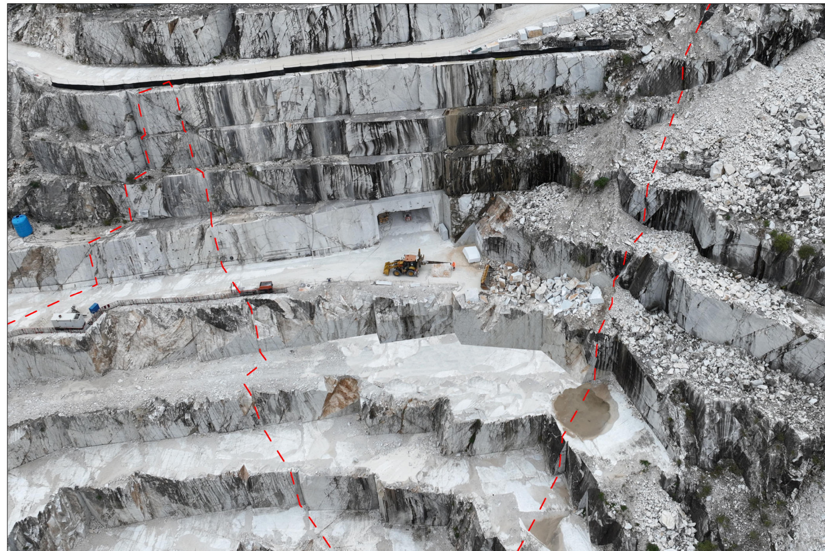
PANORAMICA STATO ATTUALE
