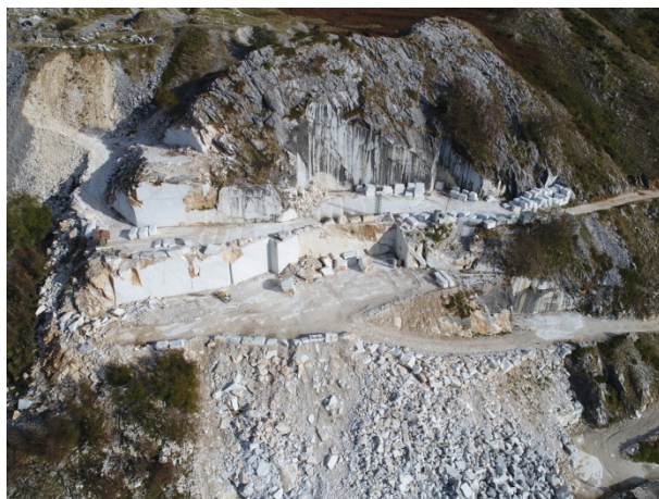
4.a) Piano di scavo- ottobre 2018
