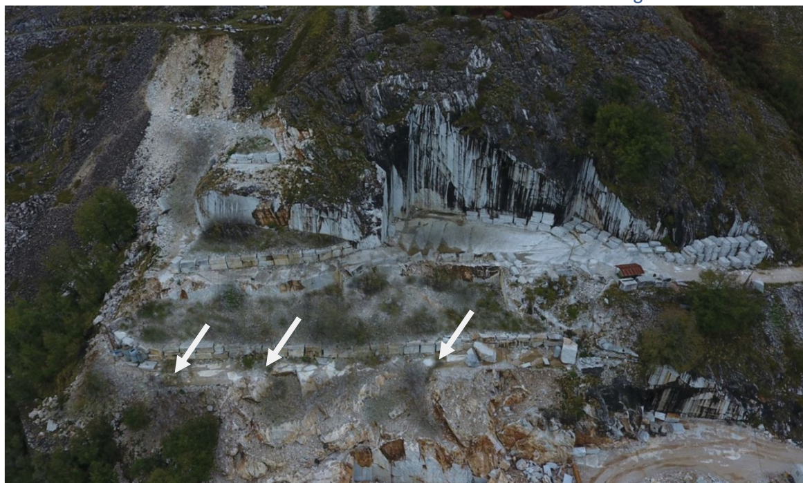
Figura 4. c) Stato a distanza di 24 mesi (2021). La rivegetazione è naturale, su un substrato terroso molto limitato; nonostante la mancanza di georeti, le pendenze sono stabili ed i muri di contenimento in blocchi, hanno permesso il deflusso controllato delle acque ( frecce ).
