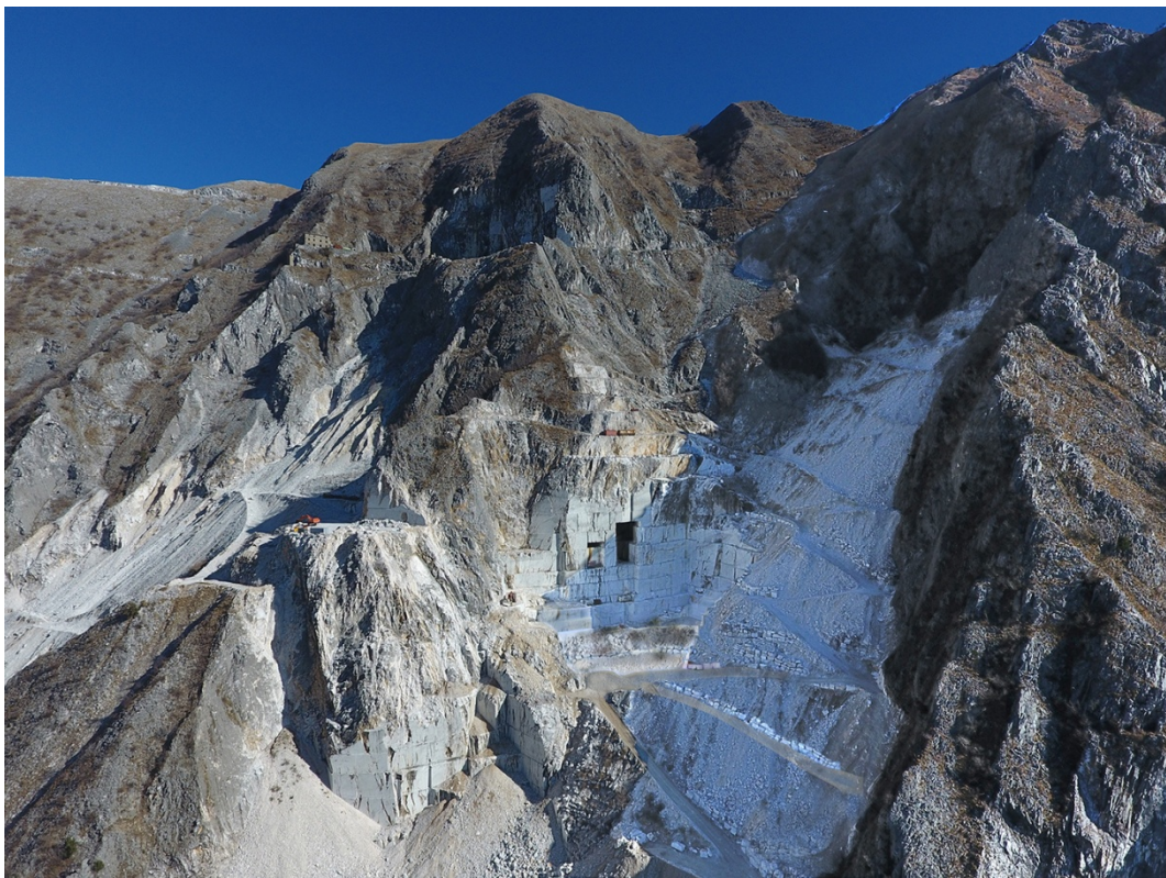
Figura 7-B- Immagine ripresa a distanza sul fronte di scavo- Progetto di coltivazione- Ripristino di fine dei lavori.
