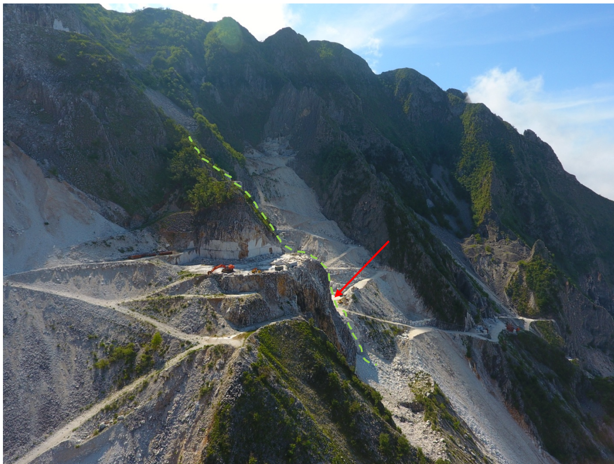
Figura 3- Una recente immagine di ripresa in ingrandimento, dal medesimo punto di vista della precedente foto, ma da drone, dalla strada per Campocecina: l'area di coltivazione non risulta visibile perchè coperta dall'estensione del crinale.
