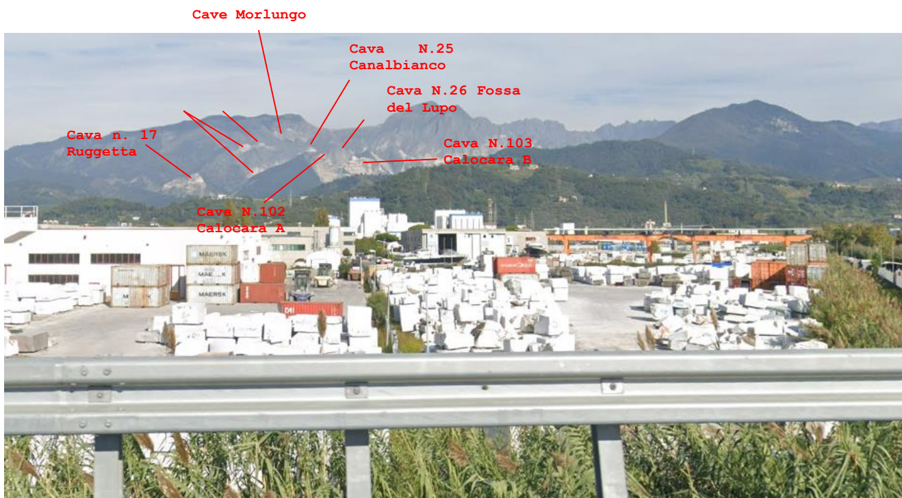
4C Tratto autostradale sopra Torrente Carrione (Comune di Carrara), Cava 26 nascosta da M. Bettogli (698m slm).
