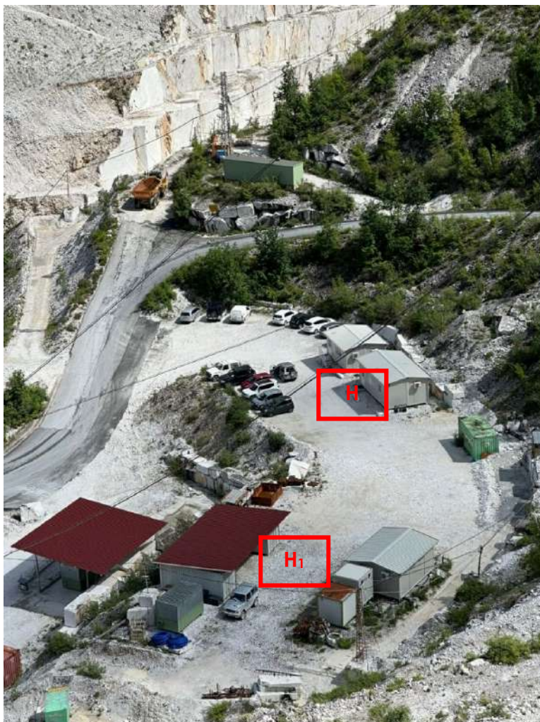
Figura 14: Panoramica delle aree impianti e servizi, con suddivisione di quest'ultima in H e H 1 , ambedue ricoperte con pietrisco 40/70mm.
