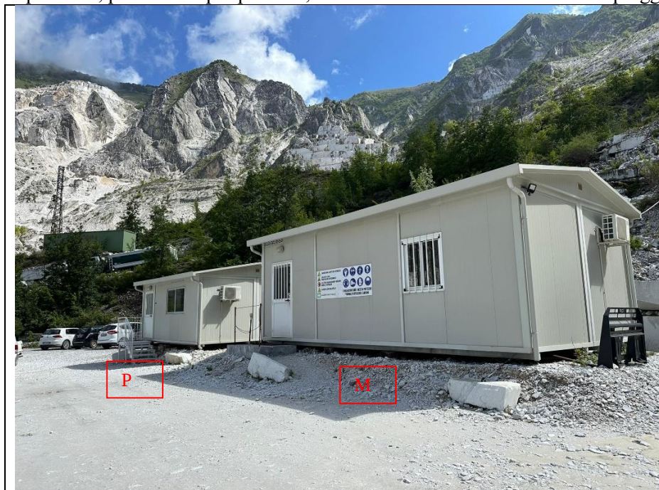
Foto 2: Vista prefabbricati adibiti come spogliatoio del personale della cava n. 26 (P) e mensa (M) si il perosnale dia mbedue le cave.
