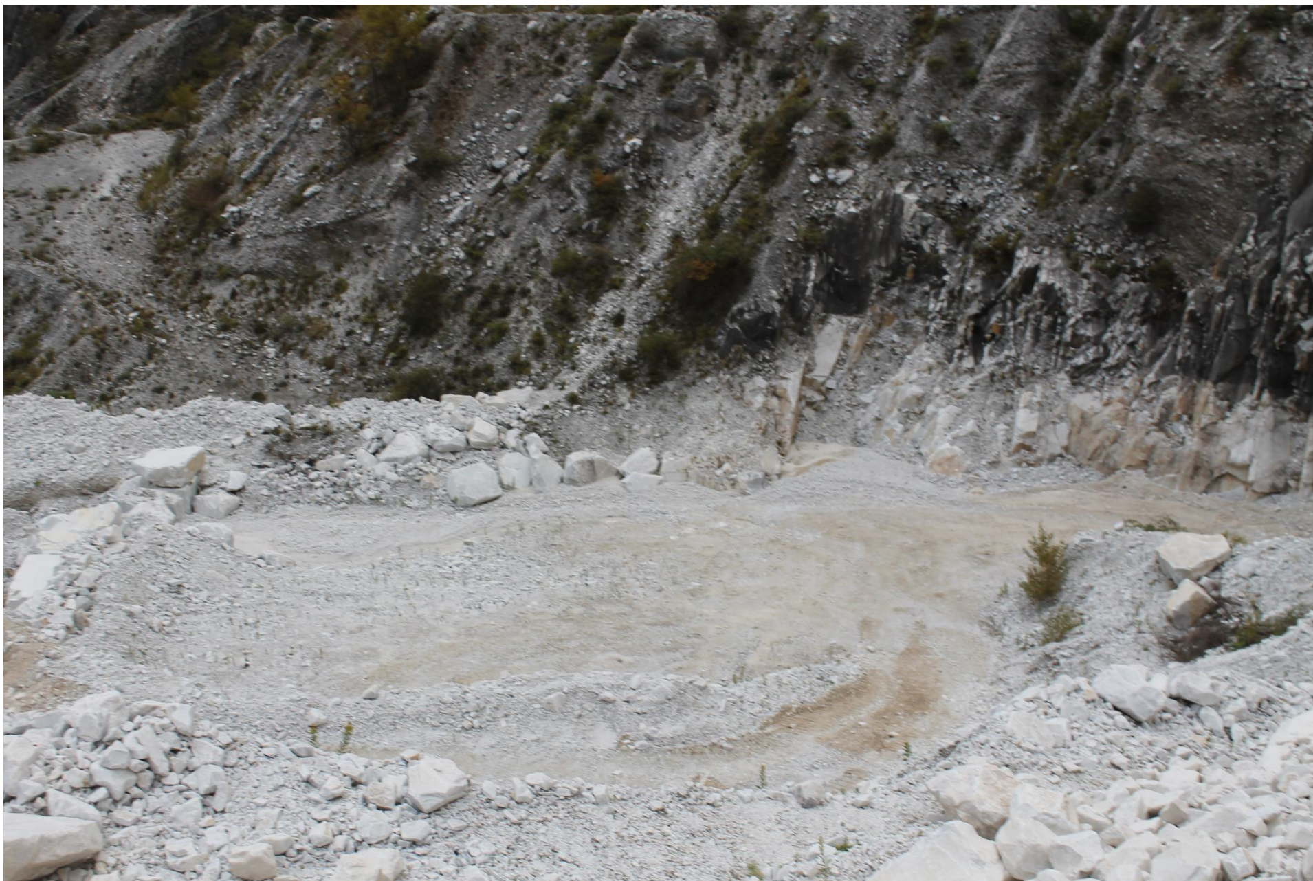
Foto 1: Vasca di laminazione con lo sbarramento in blocchi
