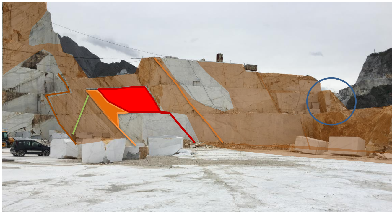
Figura 29: Ripresa del settore meridionale con indicate le principali fratture e fasce cataclastiche.
