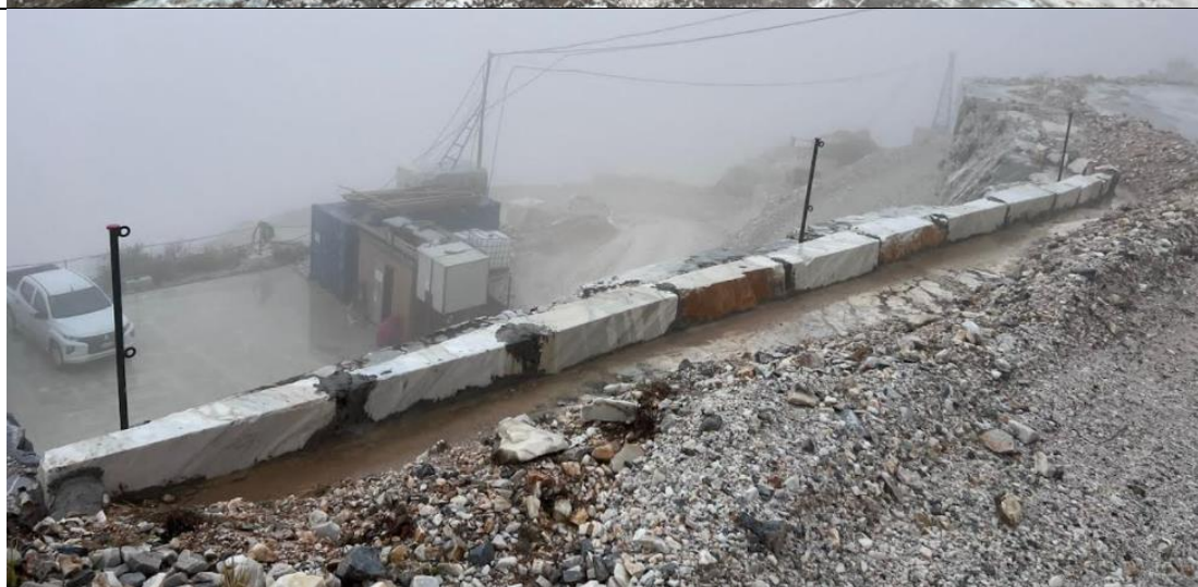
Figura 23: ripresa dell'intervento di canalizzazione in corrispondenza del gradone residuale di q. 464.2m s.l.m..
