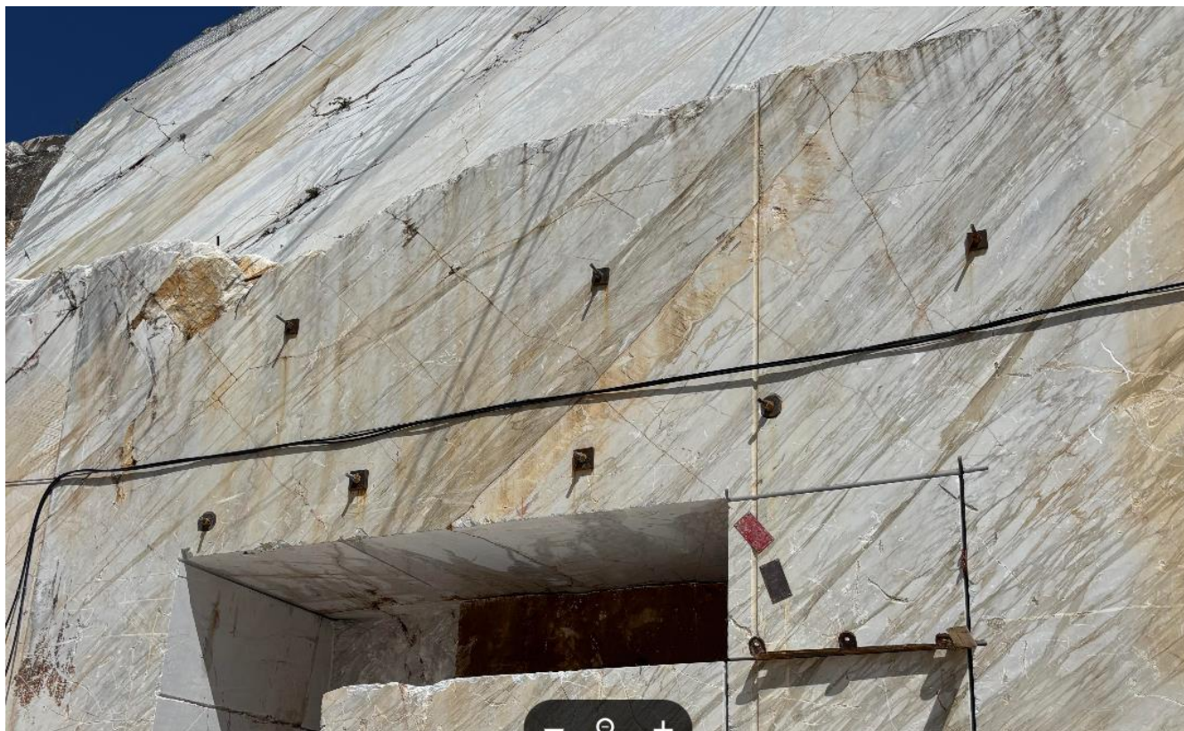
Figura 19: Ripresa dell'accesso SW del cantiere sotterraneo settentrionale.
