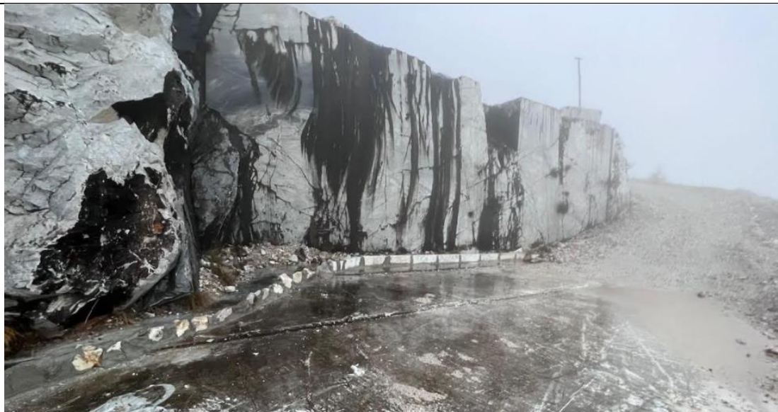
Figura 22: ripresa dell'intervento di canalizzazione in corrispondenza del gradone residuale di q. 471.9m s.l.m..
