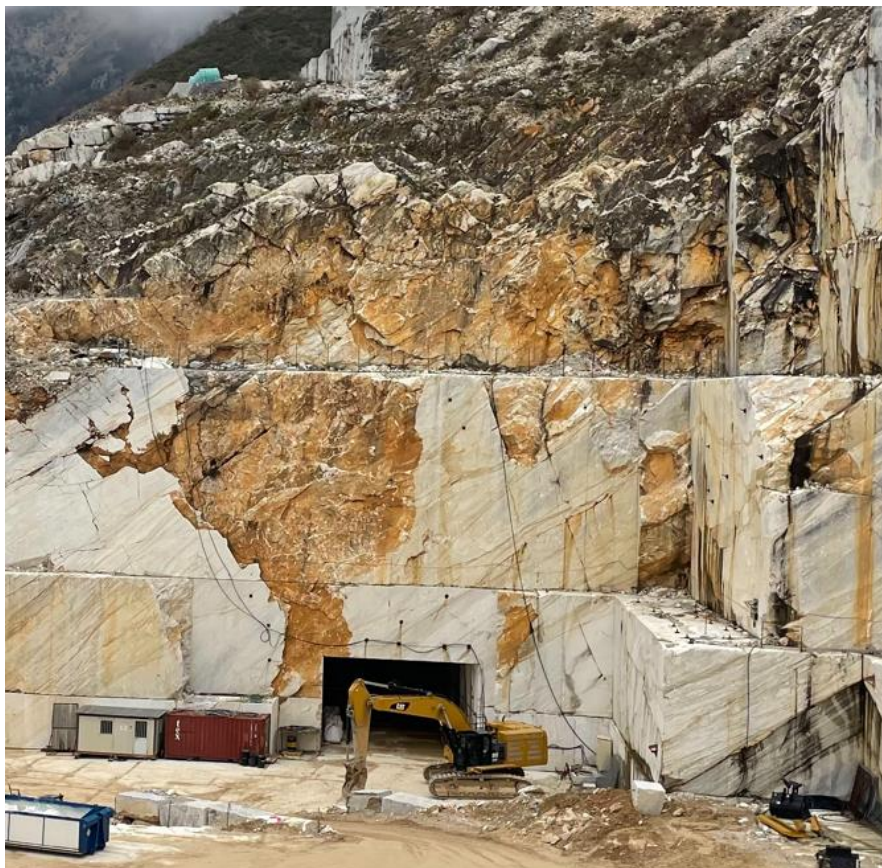
Figura 15: Condizione attuale del nuovo cantiere sotterraneo ove si evincono i consolidamenti realizzati e precedentemente dimensionati.
