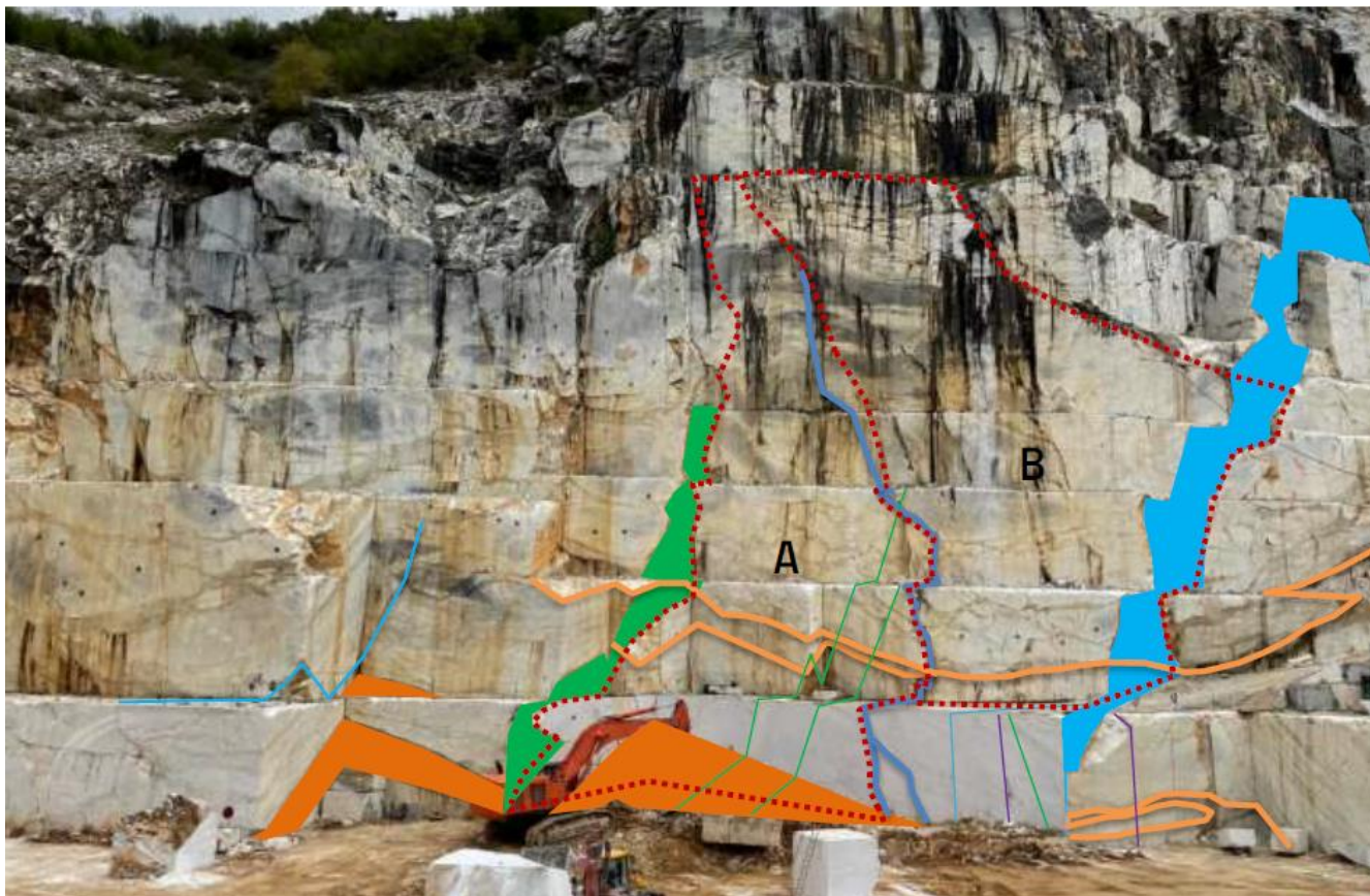
Figura 25: Ripresa panoramica della tecchia centrale settore settentrionale con indicate le principali discontinuità rintracciate a seguito degli interventi di messa in sicurezza/consolidamento.
