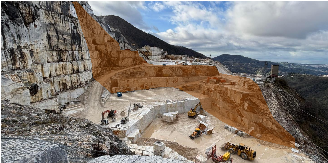
Figura 26: Ripresa panoramica della tecchia ricompresa tra i piazzali principali e la cabina elettrica con indicate le fasce cataclastiche e molto alterate..
