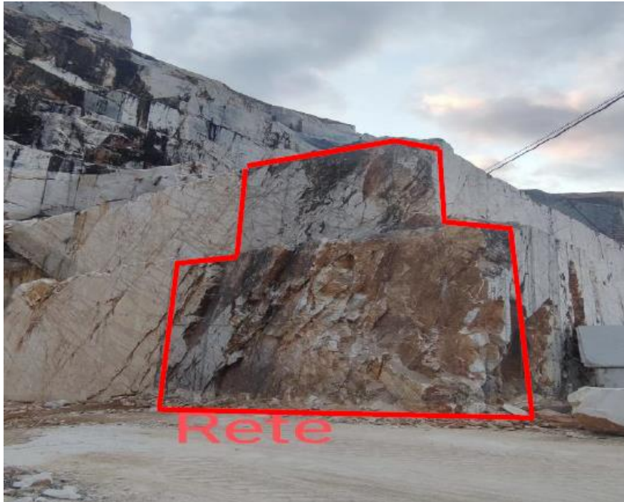
Figura 28: Intervento di messa in sicurezza del fianco settentrionale della "zampa" al settore centrale della tecchia (Relazione fine lavori Apian dicembre 2021).
