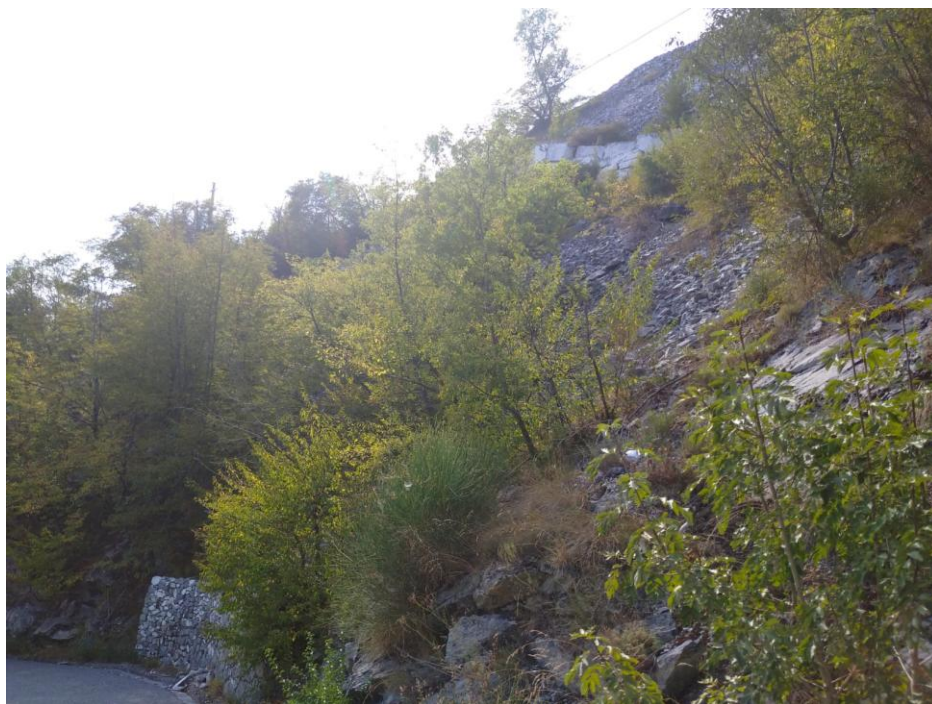
Particolare di parte del ravaneto visibile dalla strada di arroccamento.
