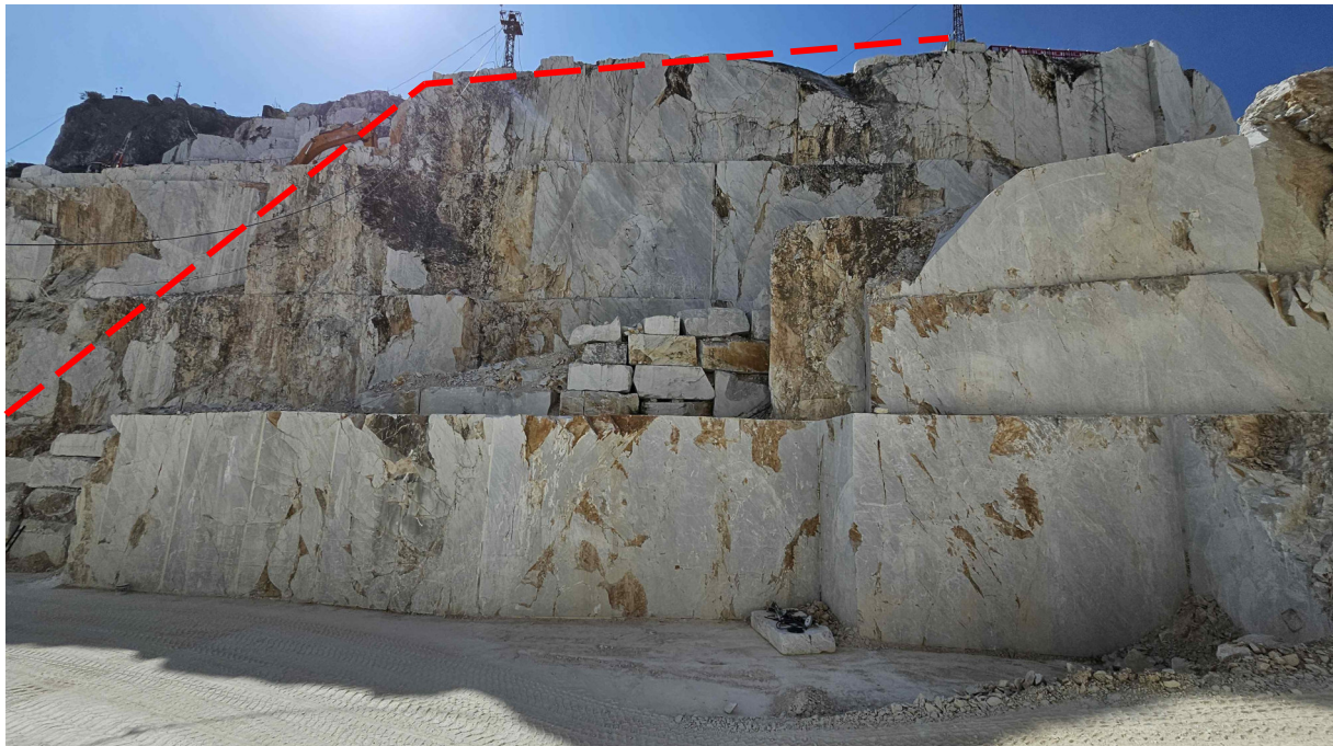
Foto 2 – Panoramica dei fronti immergenti a NW a confine (linea rossa) con la cava 153 le cui lavorazioni risultano essere una messa in sicurezza progressiva negli anni degli stessi.
