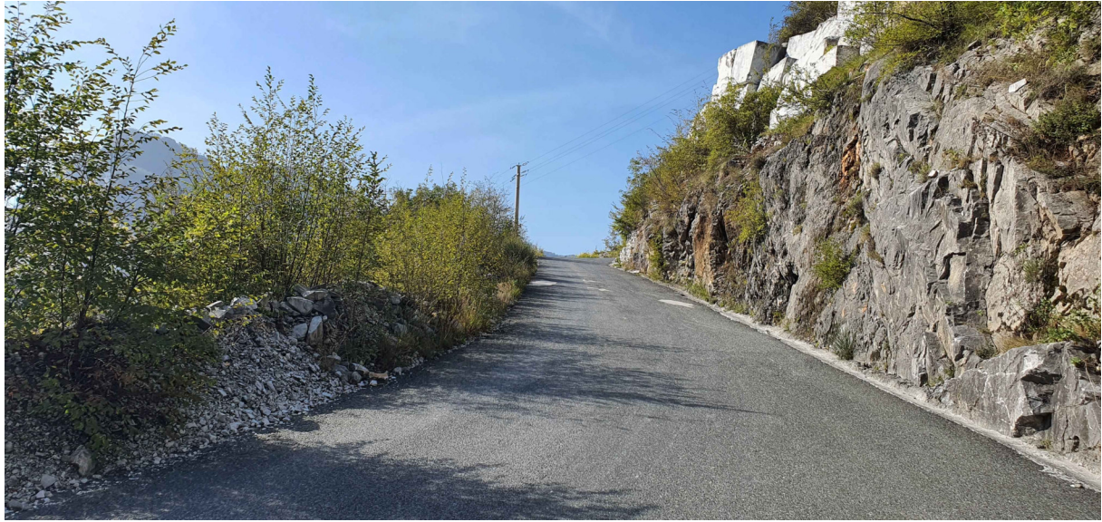
Foto 1 – Tratto di strada da modificare.
