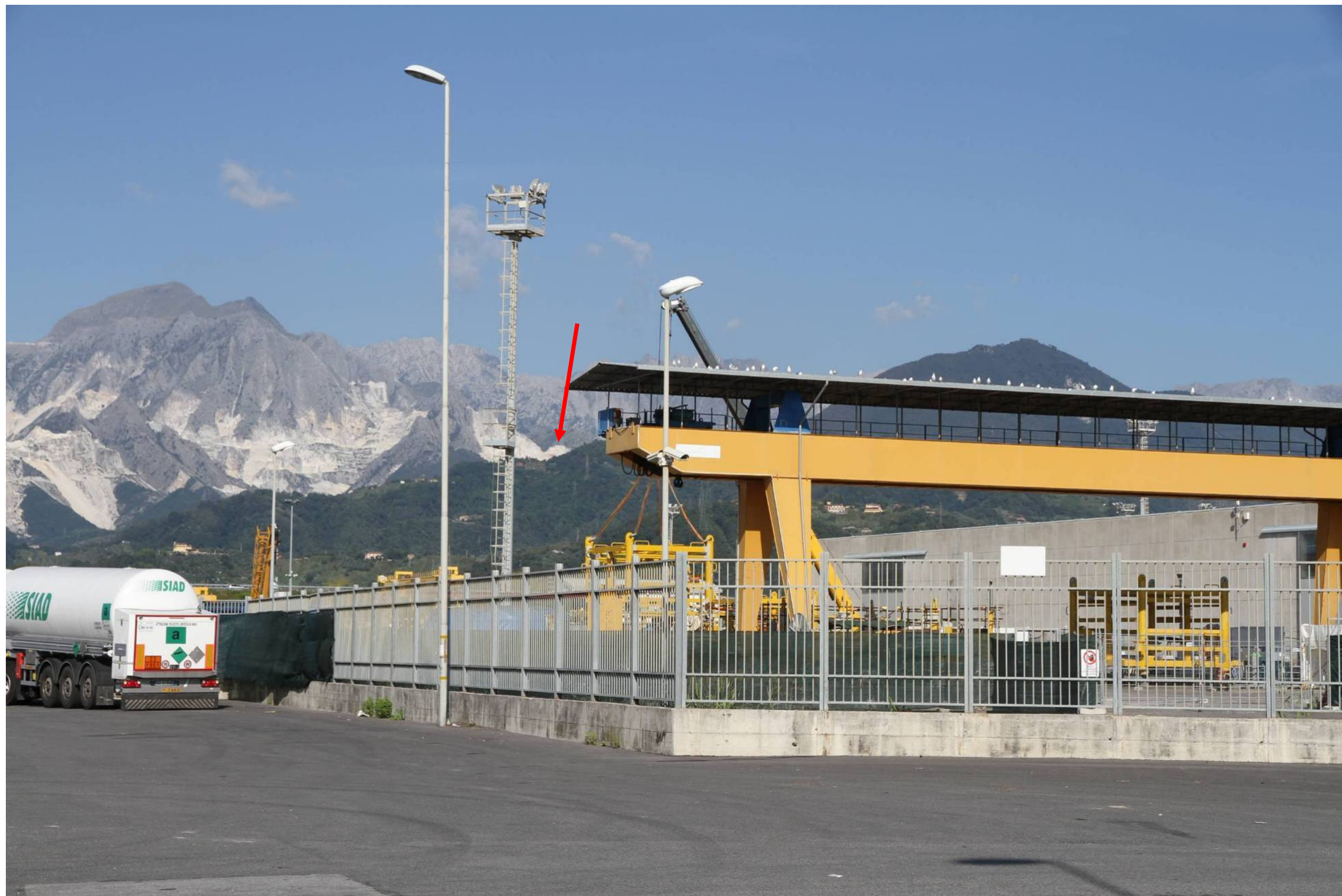
Posizione 4 - Viale Zaccagna Marina di Carrara - Indicato dalla freccia rossa il Compensorio di Campanili. Della cava n°152 risulta visibile solo la porzione dello zucco che nel presente progetto non verrà modificato
