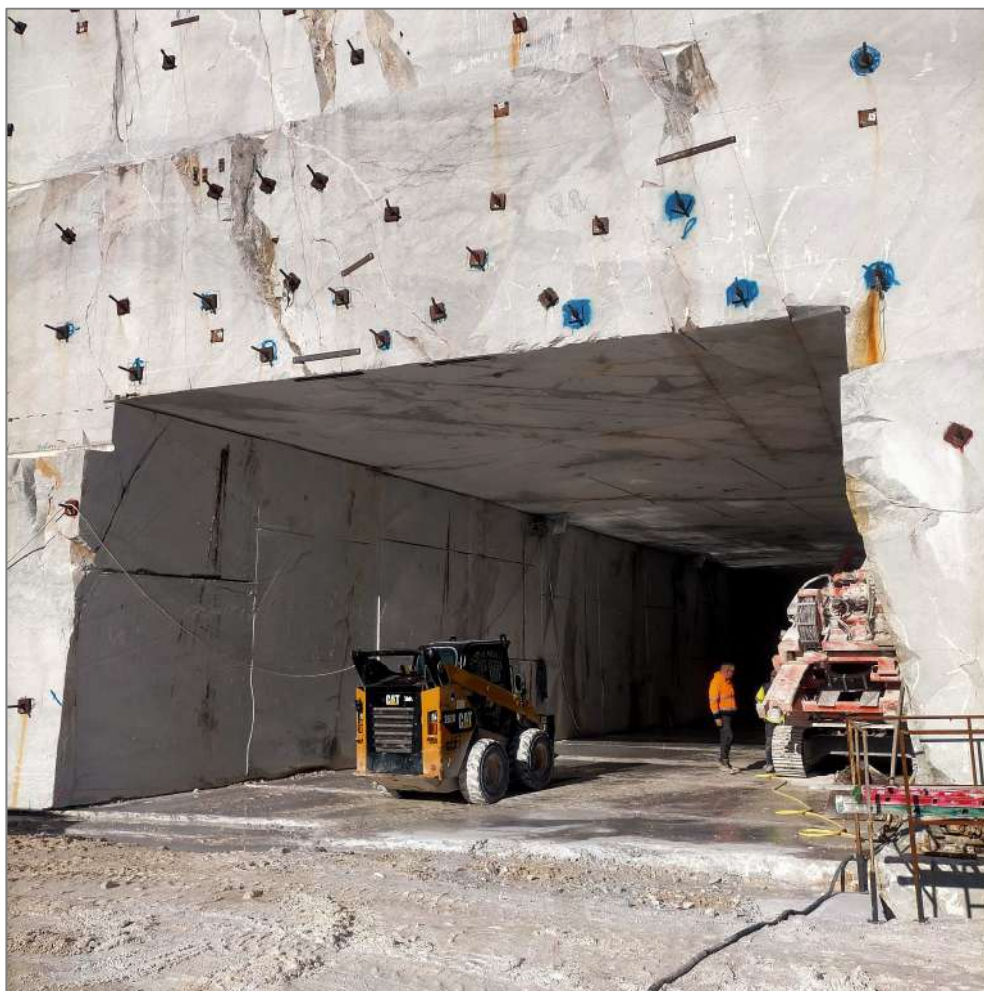
Figura 2: Imbocco della galleria Est
