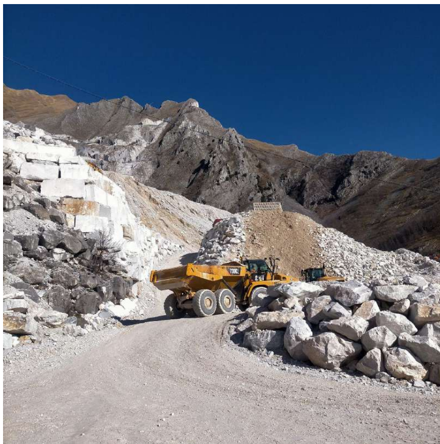
Figura 17: Operazioni di dumperaggio con allontanamento dei materiali derivati dai cantieri.
