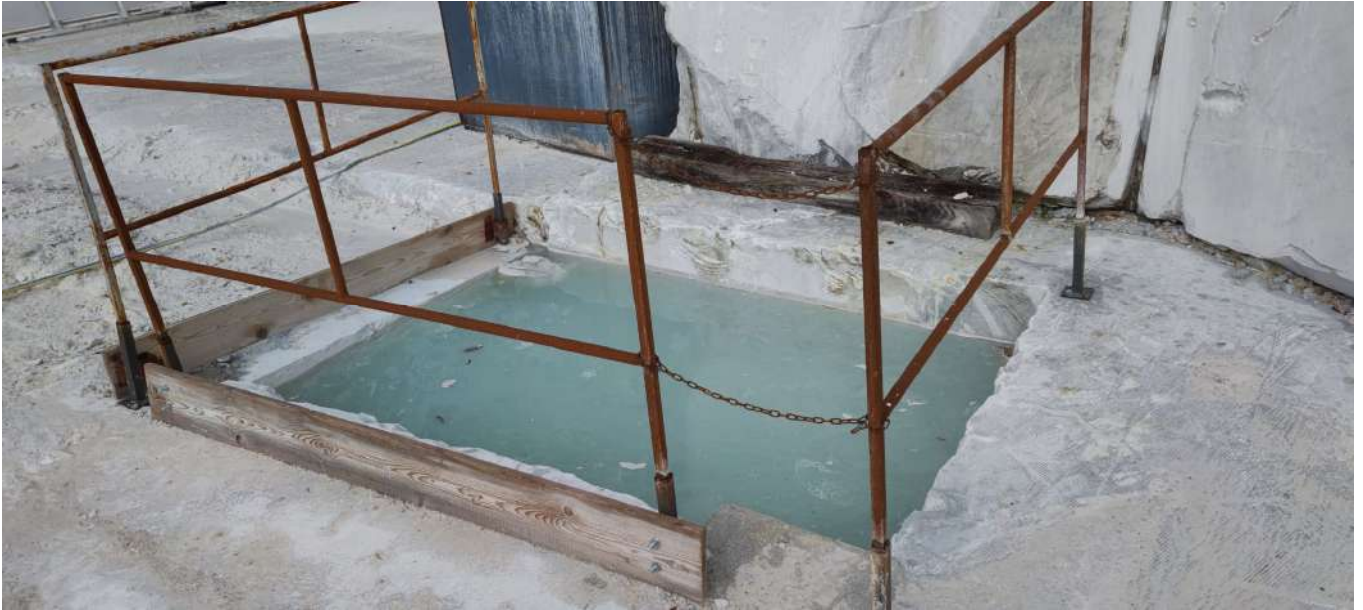
Figura 14: Vasca di raccolta delle acque sotterranee localizzata presso il portale della galleria Nord.
