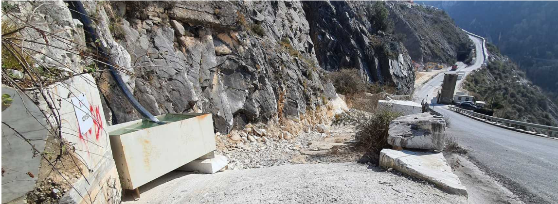
Foto 2 – Panoramica della vasca metallica dove giunge la tubazione dal piazzale di cava e del Bacino B2.
