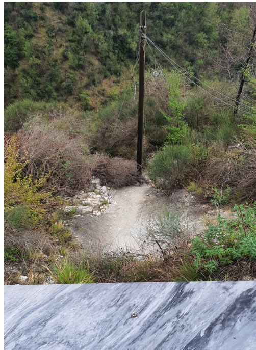
Foto 4 - Panoramica dall'alto del punto di uscita della tubazione metallica che attraversa la strada.
