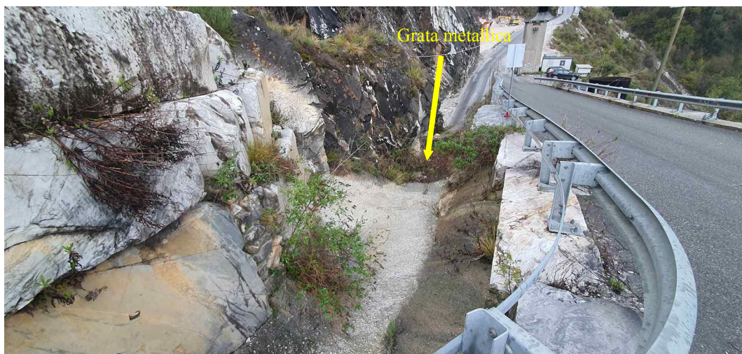
Foto 3 - Panoramica della canaletta cementata posto a valle del Bacino B2.
