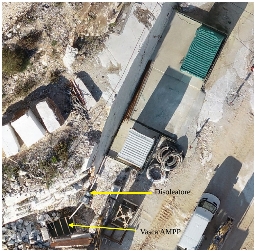
Panoramica dell'area impianti.
