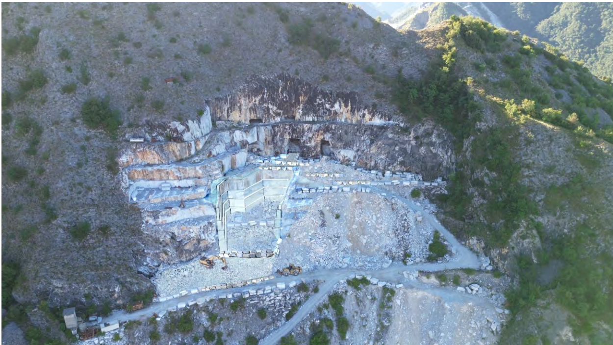
FR-02 Fase di ricostruzione
