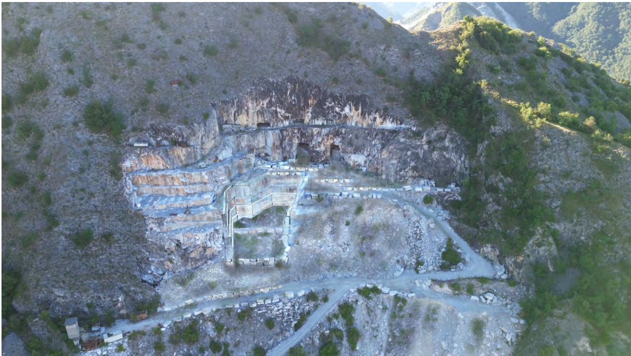
FR-03 Fase di ricostruzione completata Rinaturalizzazione
