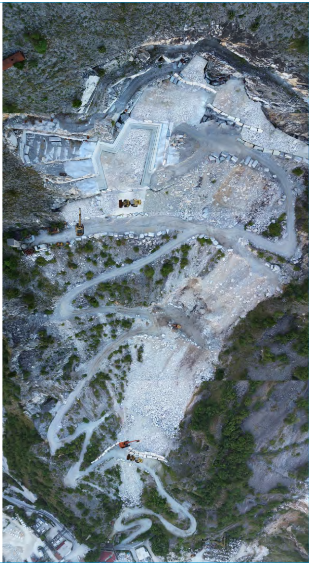
FR-02 Fase di ricostruzione
