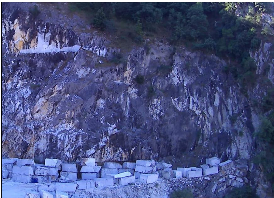
Foto 3 – Porzione di tecchia residuale sottoposta a provvedimento n.21/2020
