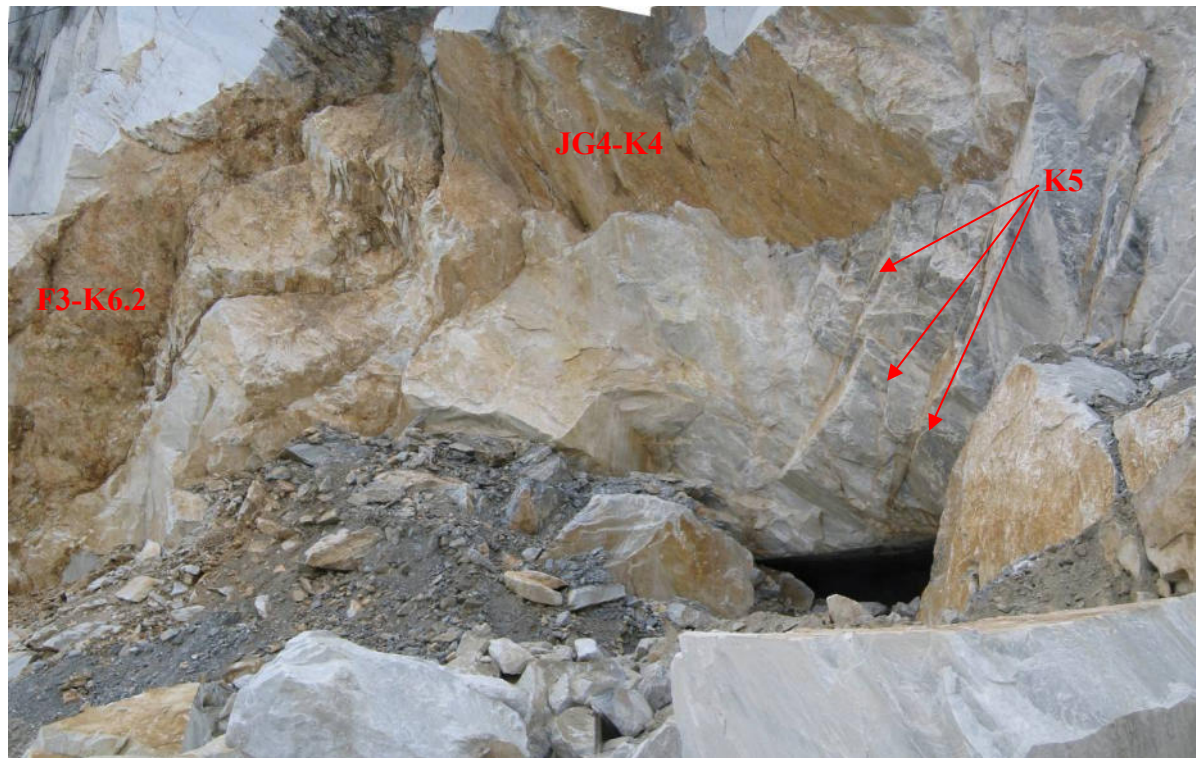
Foto 2 – Particolare sul prisma presente nell'area residuale di frana con indicazione delle discontinuità principali che lo delimitano.
