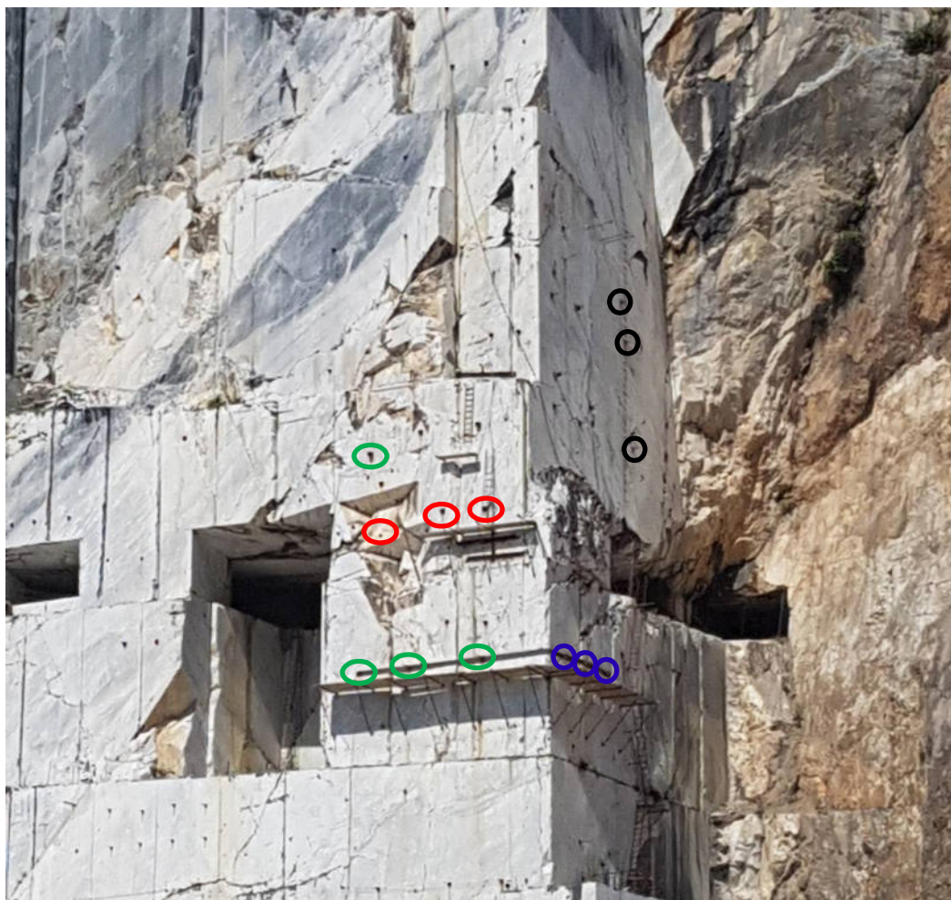
Figura c – indicazione dei tiranti posizionati nel 2017/2018
