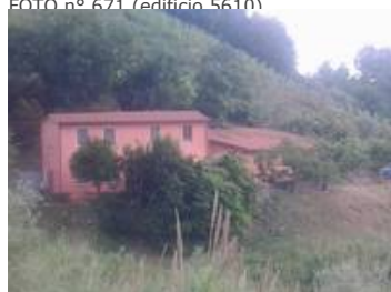
FOTO n.º 671 (edificio 5610)
