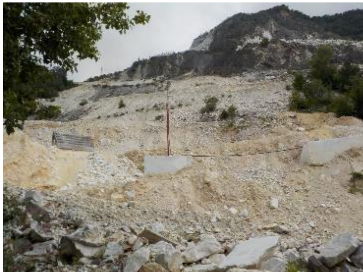
Figura 9 - Ravaneto composto da materiale fine e privo di copertura vegetale.
