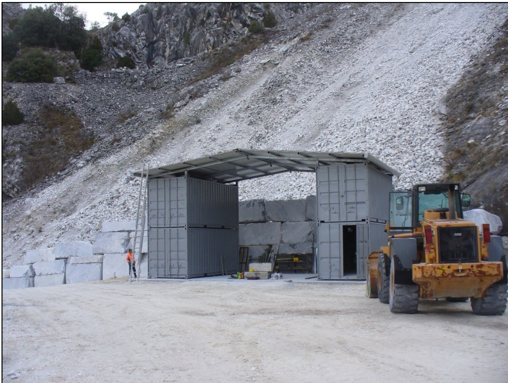
Foto n. 4: interventi di messa in sicurezza dell'area di escavazione della cava "Valpulita" mediante bastionatura in blocchi alla base del ravaneto a monte dell'area impianti
