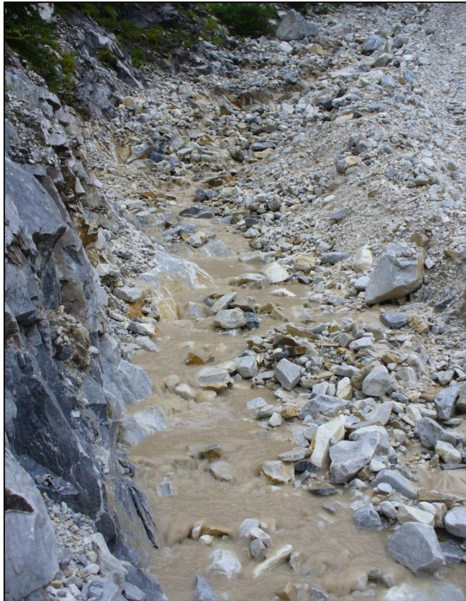
Foto n. 1: canaletta di drenaggio realizzata a lato della strada di arroccamento
