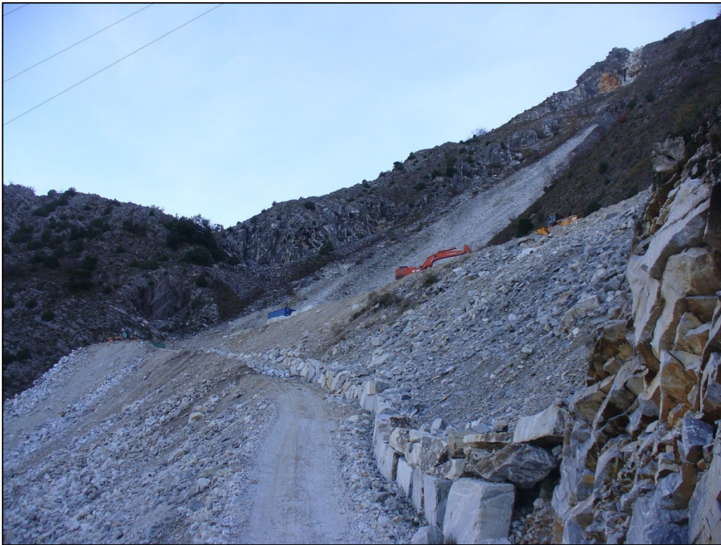
Foto n. 3: interventi di messa in sicurezza del ravaneto mediante bastionatura in blocchi sul lato di monte della strada di arroccamento
