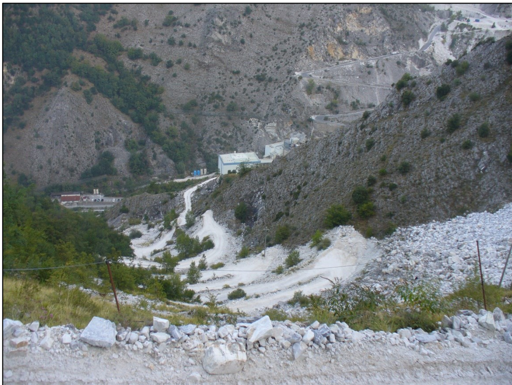
Foto n. 2: aree di rallentamento idrico in corrispondenza dei tornanti della strada di arroccamento
